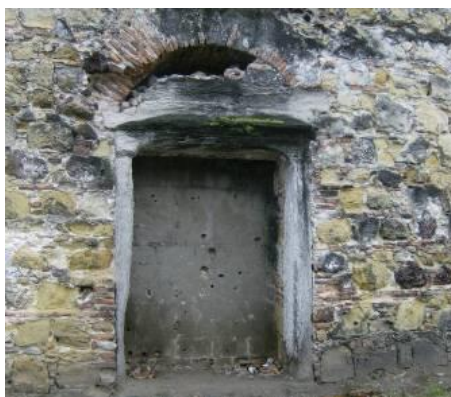
Ilustração 10- Arco pleno construído em alvenaria de tijolos cerâmicos.
