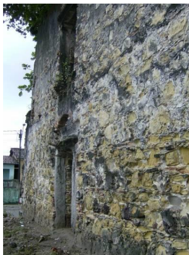
Ilustração 8- Vista da parede em pedras.
