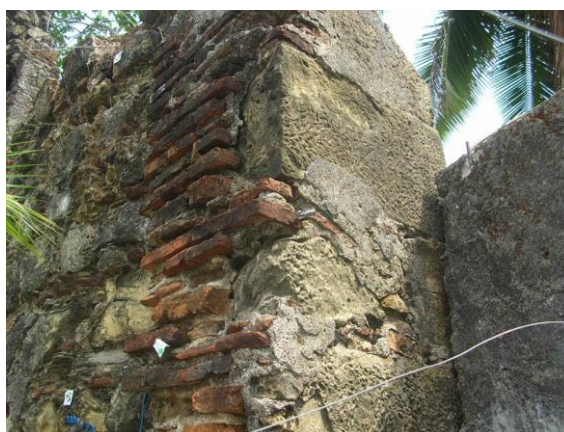
Ilustração 7 - Cunhais em pedras aparelhadas definidoras das arestas externas.
