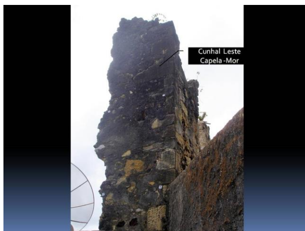
Ilustração 6 – vista do cunhal em pedras aparelhadas definidoras das arestas externas.
