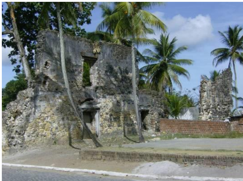
Ilustração 4 - Vista geral da face da ilharga que confronta a ventilação Sudeste.
