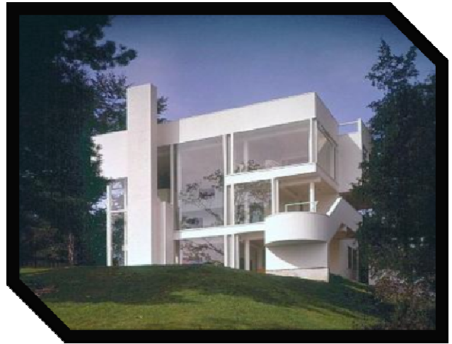
Figura 01. Fachada da casa. Darien, Connecticut 1965.
