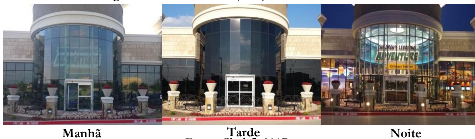
Figura 6 – Fachada com aplicação do vidro dinâmico
