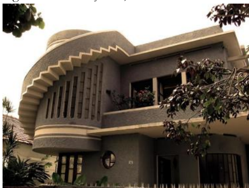
Figura 3: Casa protorracionalista na Avenida Sigismundo Gonçalves, Carmo.
