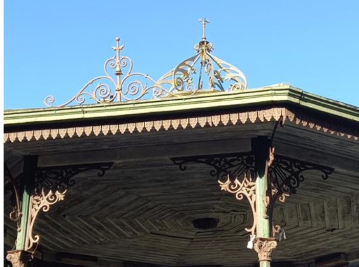
Figura 18: Coreto de Olinda, detalhe da coberta.
