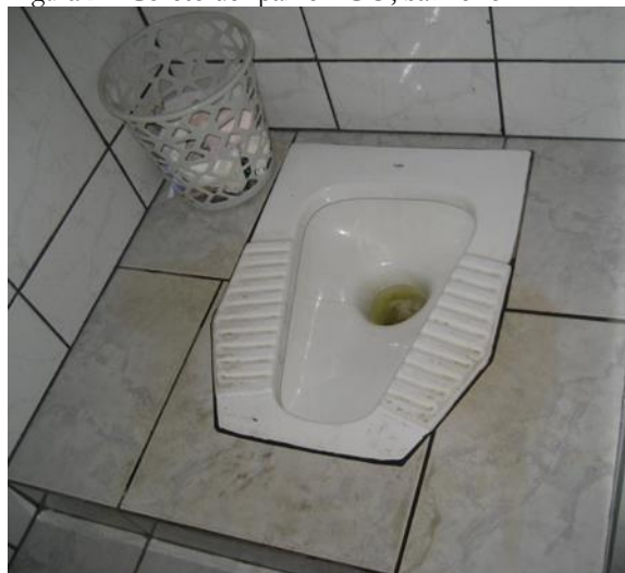
Figura 21: Coreto de Ipameri-GO, banheiro.
