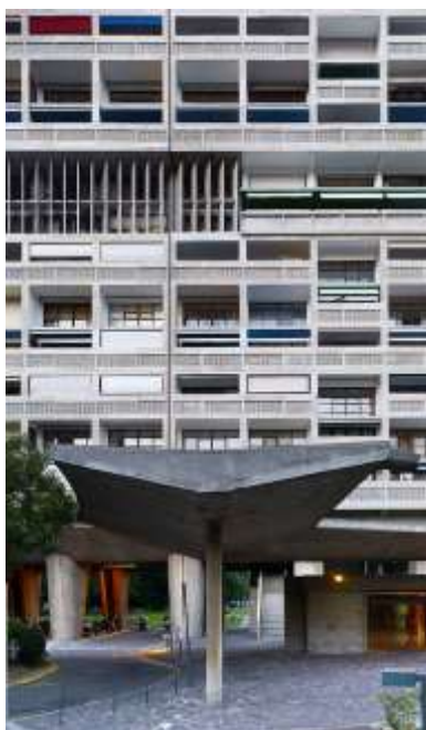
Figura 08 - Marquise da entrada principal.
