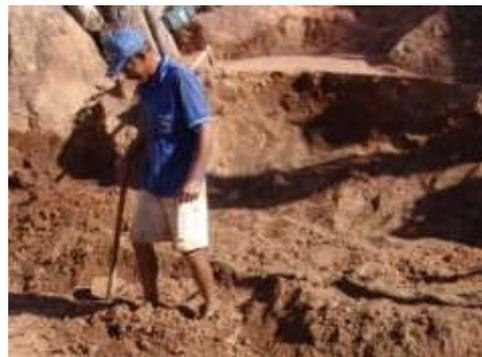
Figura 10: Amassamento do barro e retirada de pedriscos.
