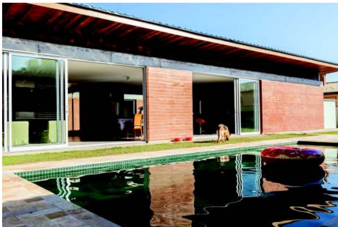
Fig. 15 – Fachada do segundo bloco, com vista da piscina.
