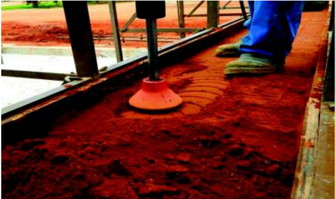
Fig. 12 – Compactação da terra na confecção da parede.
