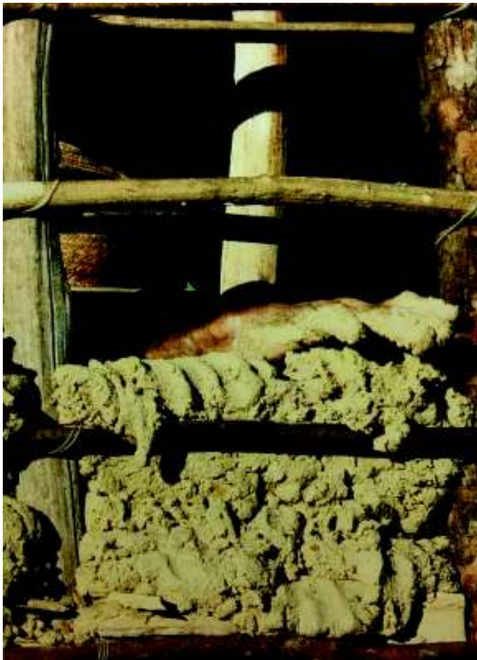
Fig. 10 – Confecção de parede - taipa de mão.
