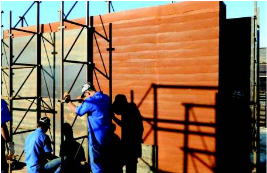
Fig. 11 – Confecção de parede - taipa de pilão mecanizada.
