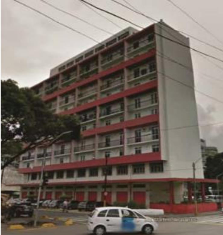
Foto 21: Edifício Inconfidência (IAPI)
