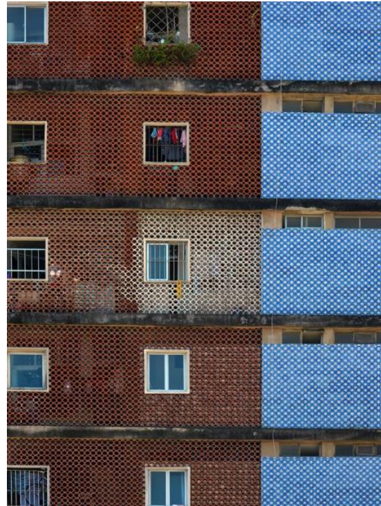
Figura 55: Detalhes dos cobogós e azulejos
