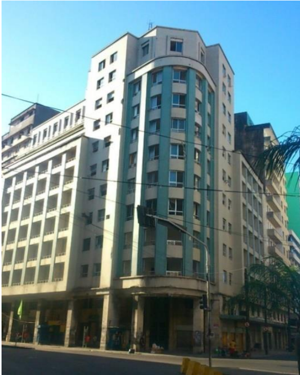
Foto 17: Edifício Santo Albino
