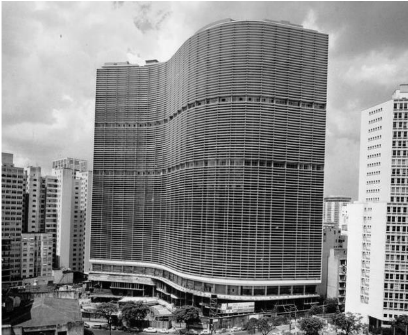
Foto 10: Edifício COPAN – São Paulo
