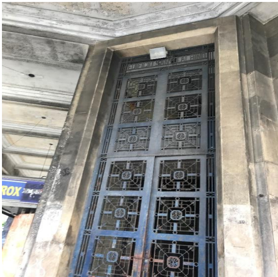
Foto 18: Grade em ferro forjado.
