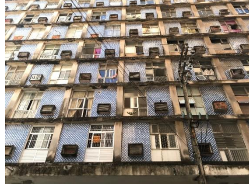
Foto 53: Detalhe da estrutura e azulejos
