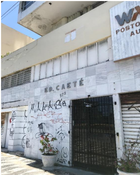
Foto 32: Pavimento térreo e sobreloja .
