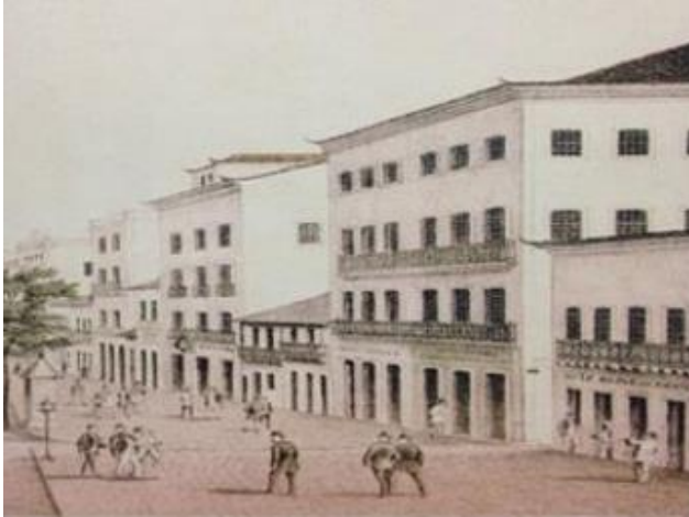
Figura 05: Casas térreas e sobrados no Recife.
