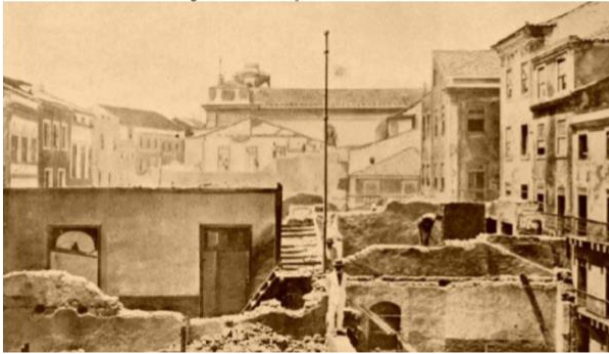
Foto 04: Demolição do Bairro do Recife
