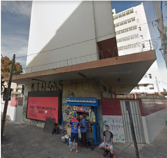
Foto 22: Edifício Inconfidência (IAPI).
