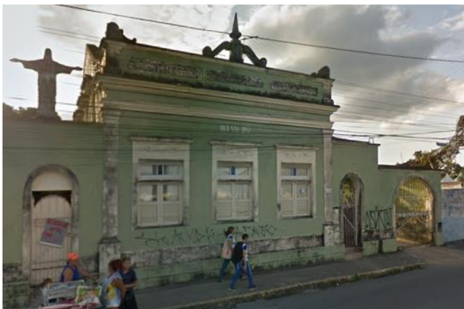
Imagem 4 - IEP nº 103 situado na Av. Afonso Olindense, 605
