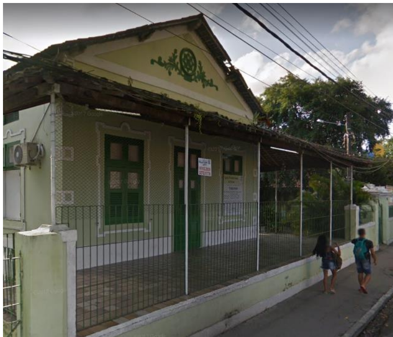
Imagem 3 - IEP nº 98 situado na Av. Afonso Olindense, 2070
