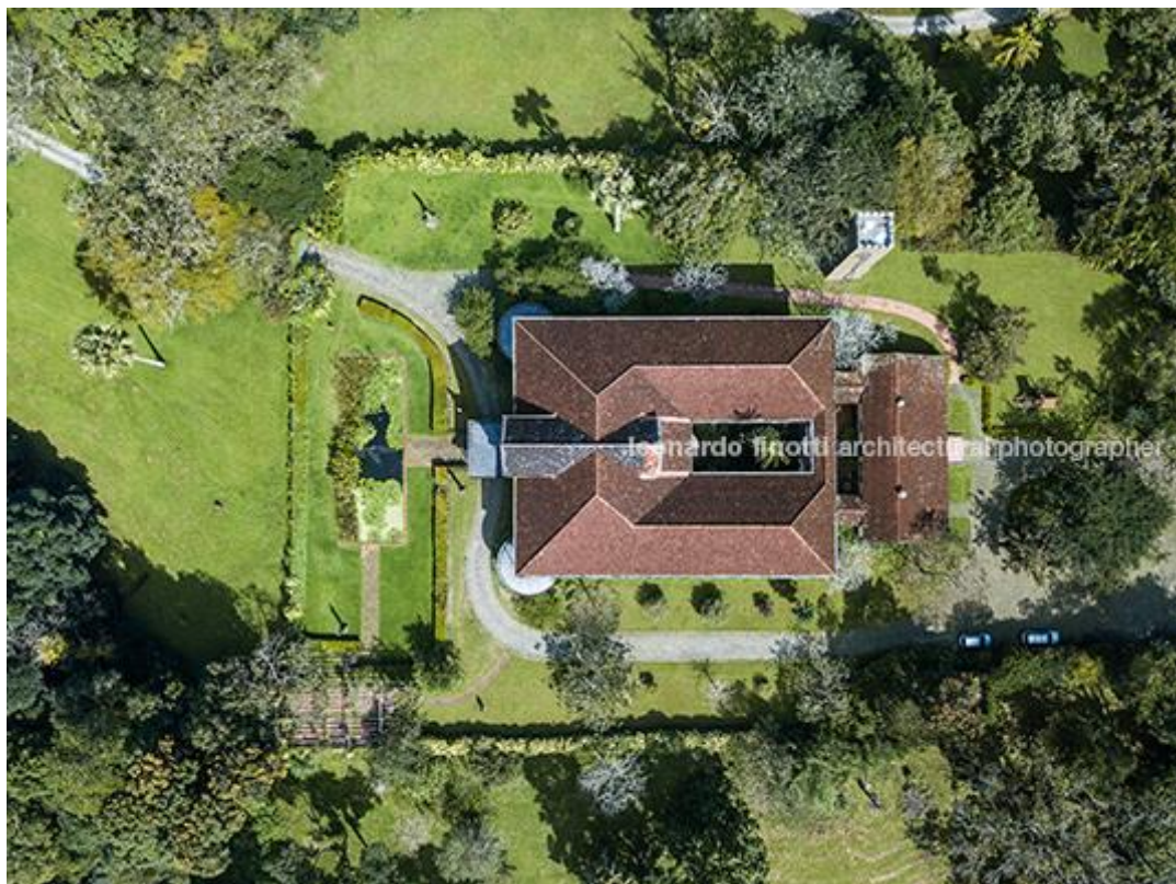
Imagem 1 - Casa de Ferro - Vista superior
