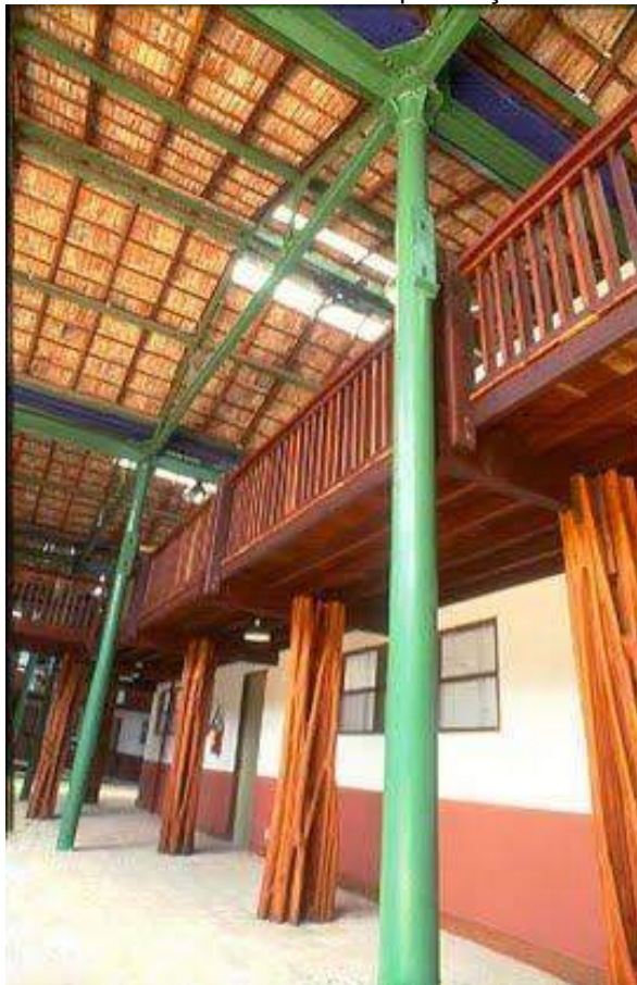
Foto 38 - Pé direito elevado com a presença de mezaninos
