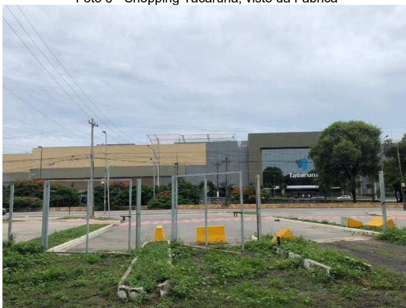
Foto 6 - Shopping Tacaruna, visto da Fábrica
