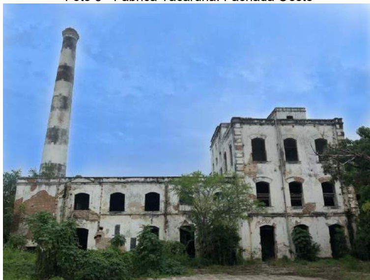
Foto 3 - Fábrica Tacaruna. Fachada Oeste
