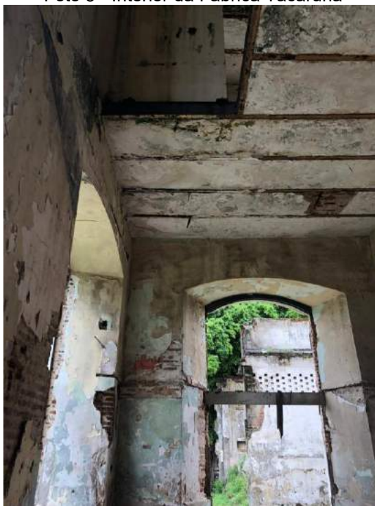
Foto 5 - Interior da Fábrica Tacaruna
