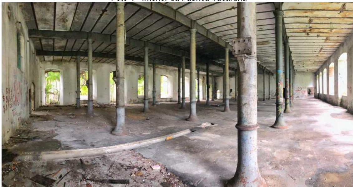
Foto 4 - Interior da Fábrica Tacaruna
