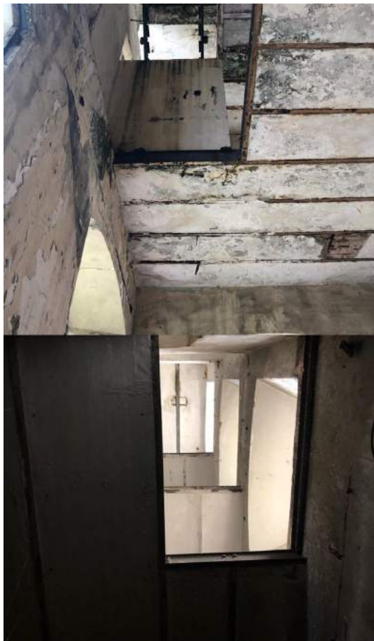
Foto 13 - Local onde se encontrariam as escadas originais
