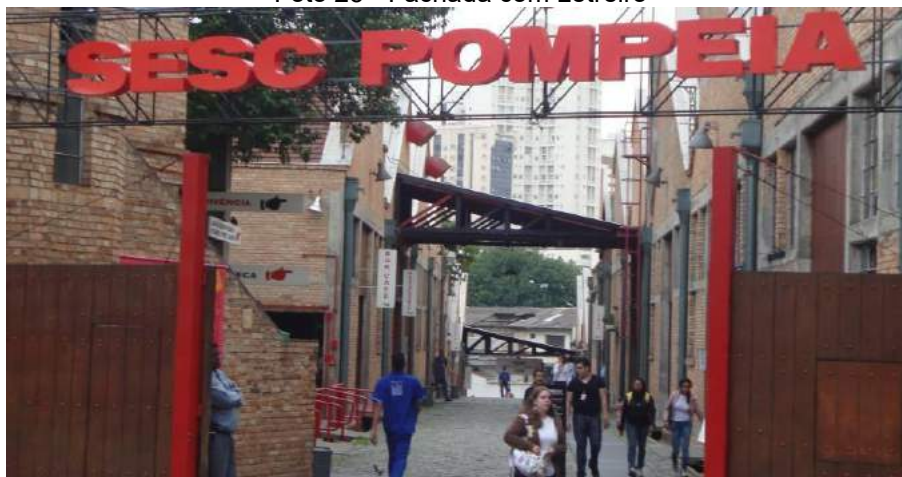
Foto 25 - Fachada com Letreiro
