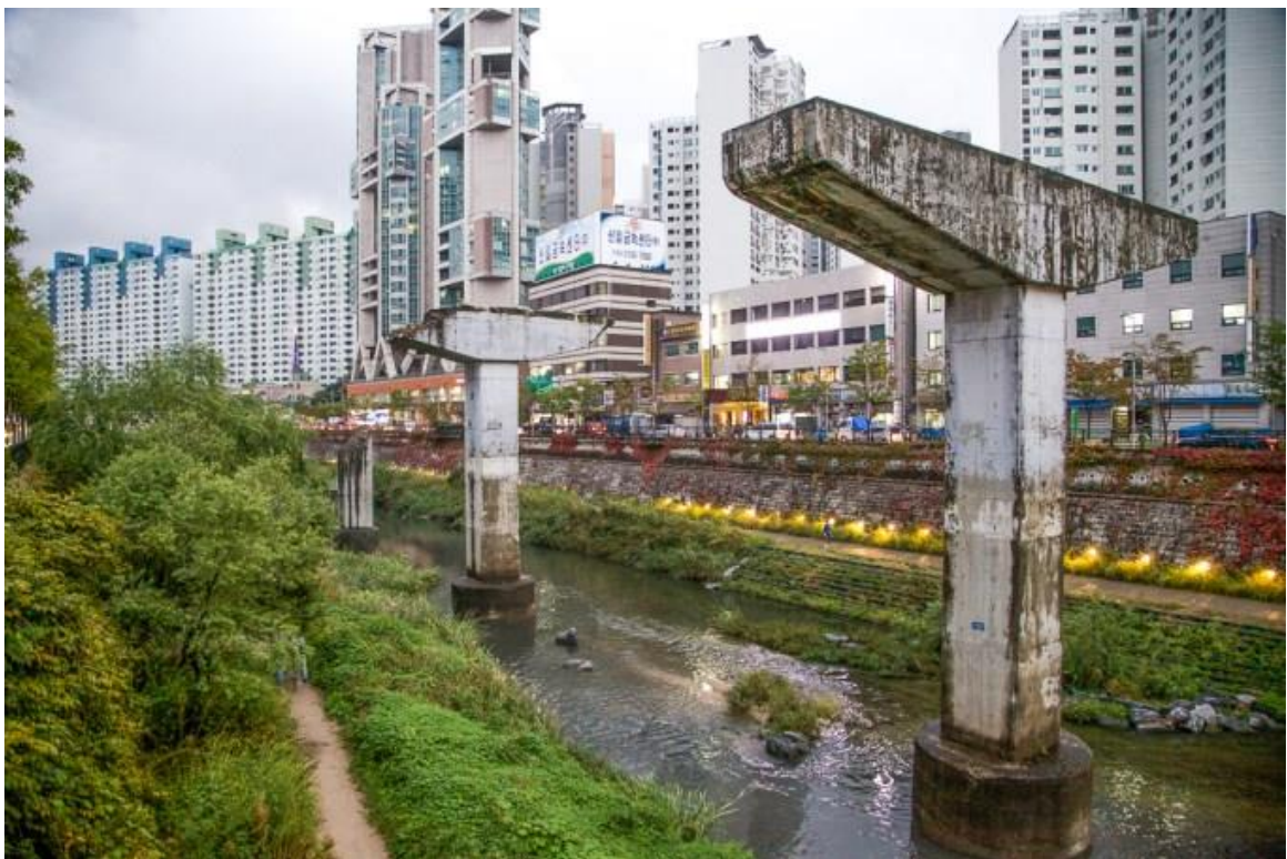
Figura 18 – Pilares da antiga Via Expressa
