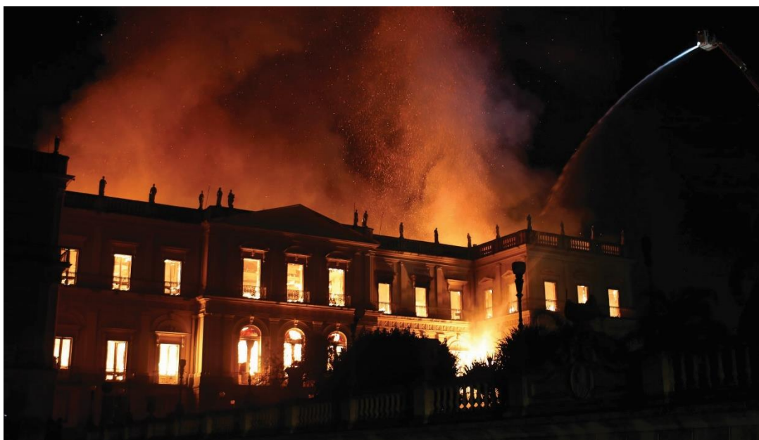
Figura 6 – Incêndio no Museu Nacional do Rio de Janeiro (setembro/2019).
