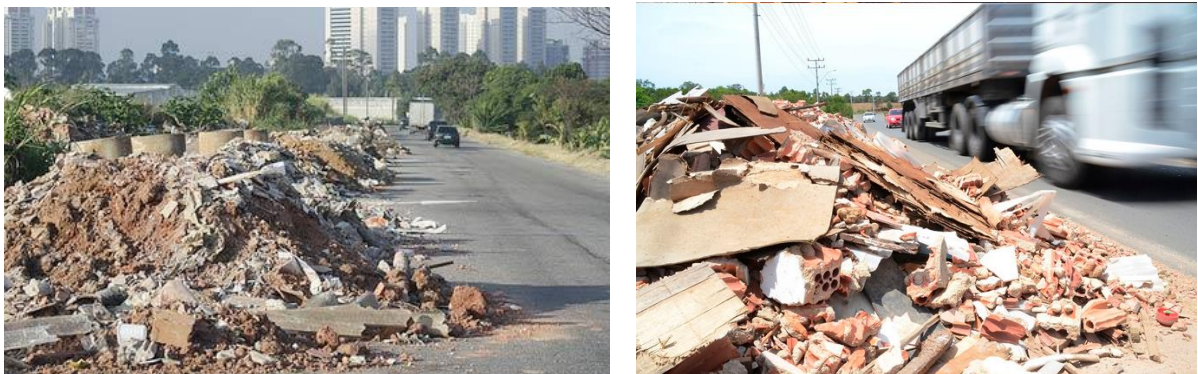
Figura 10 - Disposição Irregular de Resíduos da Construção Civil
