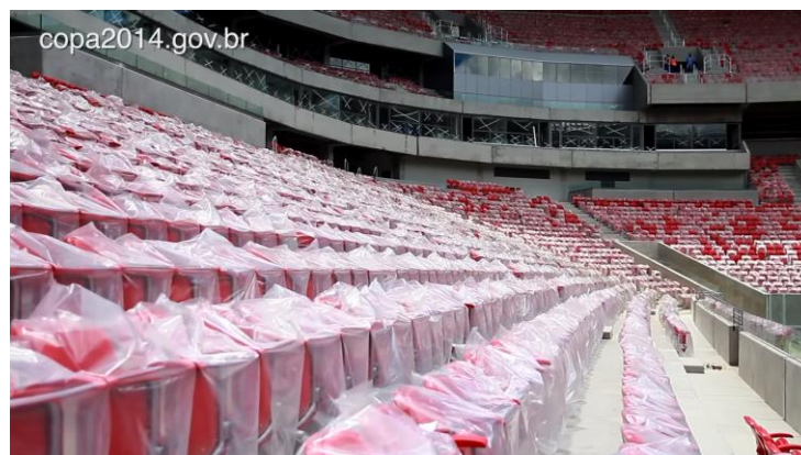
Figura 24 - Arquibancada protegida por sacos plásticos
