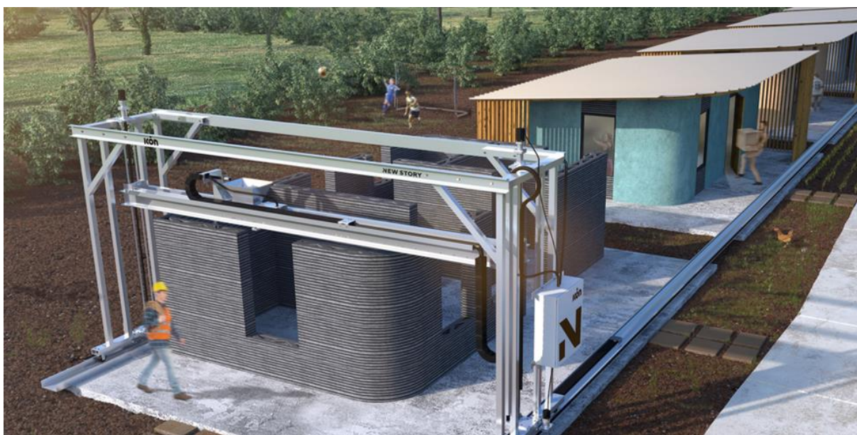
Figura 22. Montagem da casa com impressora 3D Vulcan
