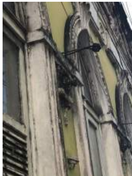
Figura 36 – Estado Atual das Molduras das Janelas
