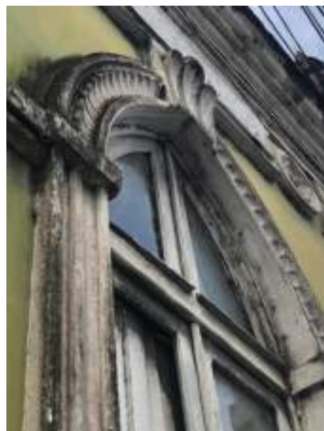
Figura 41 - Estado Atual das Molduras das Janelas
