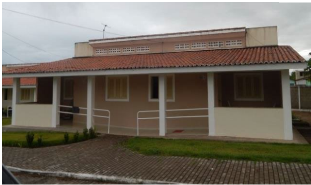
Figura 38 – Fachada com rampa de acesso
