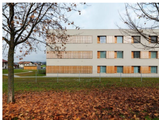
Figura 17 - Fachada da Casa de Repouso Maria Gail
