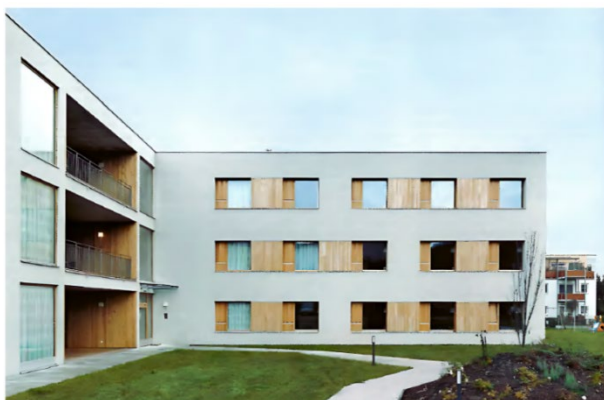
Figura 16 - Fachada da Casa de Repouso Maria Gail
