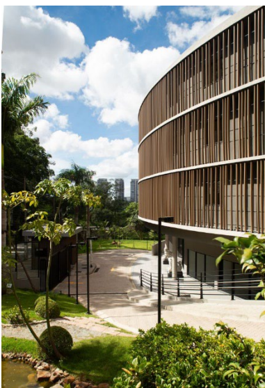
Figura 32 – Fachada com brise
