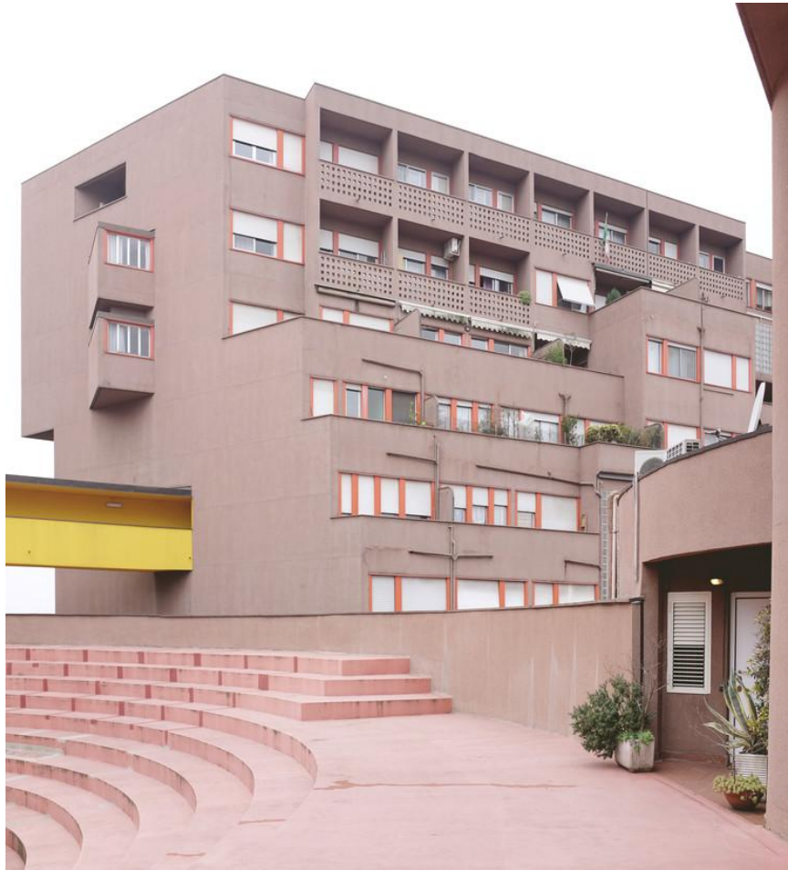
Figura 3 – Fotografia de fachada lateral dos conjuntos residenciais do bairro Gallartase
