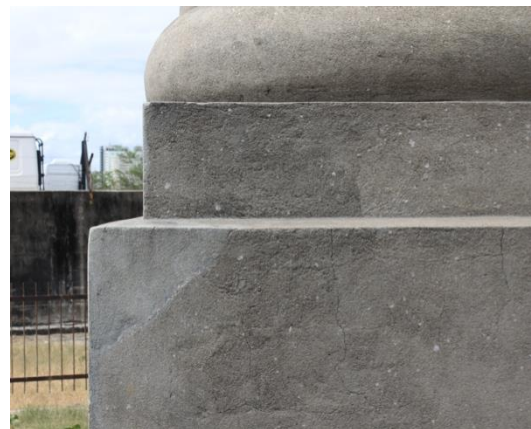
FIGURA 26: Restauração executada da recomposição da base da coluna. FONTE: Acervo da autora, novembro de 2012.
