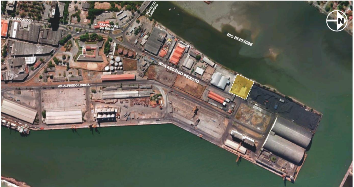
FIGURA 4: Acesso ao terreno da Cruz do Patrão - Data da imagem: 25/11/2009 FONTE: Google Earth, adaptado pela autora, 2012.
