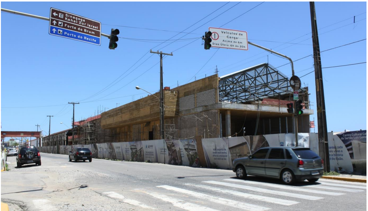
FIGURA 44: Imagens das obras de construção do Projeto Porto Novo - parte do Cais do Sertão Luiz Gonzaga.
