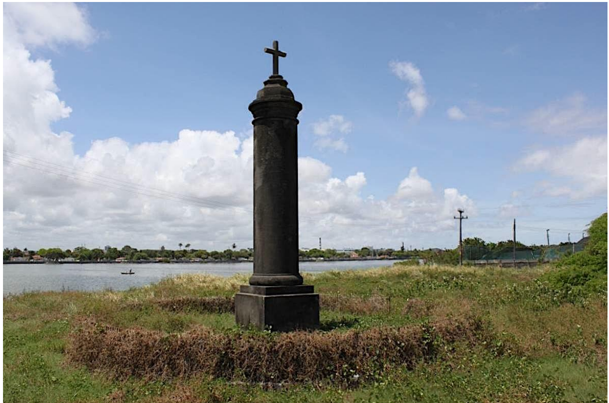
FIGURA 15: Vista da Cruz do Patrão – a vegetação cobrindo toda a pavimentação e o gradil de ferro.
