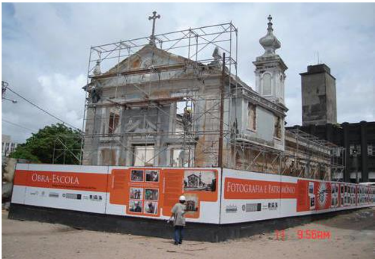
FIGURA 38: Imagem do início das obras de Restauração da Igreja do Pilar. FONTE: IPHAN/2009
