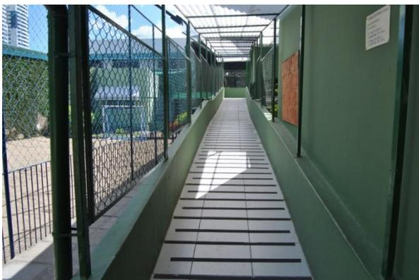
**FIGURA 40:** Rampa com piso antiderrapante
