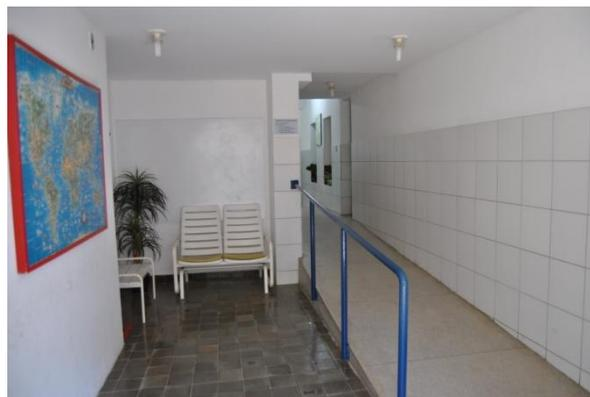
**FIGURA 37:** Barra de apoio e rampa
