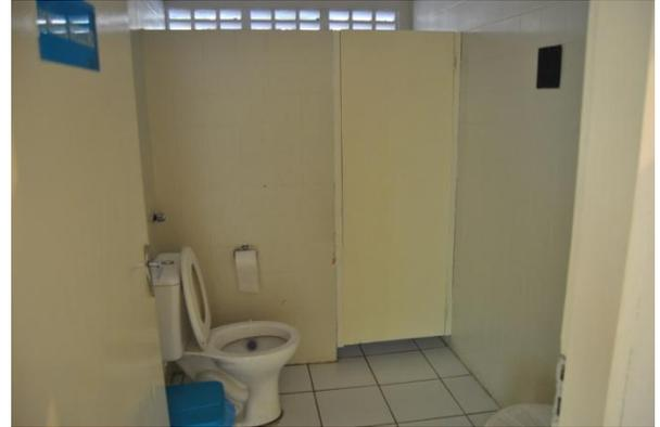
**FIGURA 77:** Ausência de barras de apoio
