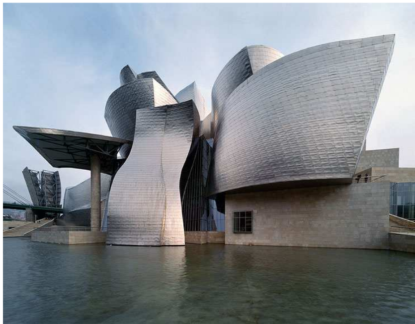
FIGURA 17: Museu Guggenheim Bilbao FONTE: Edificando Online, 2011
