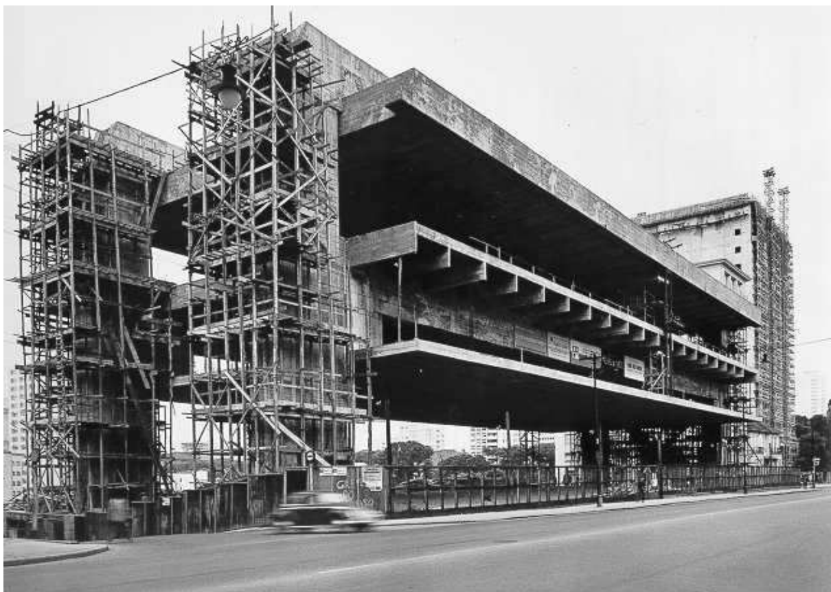
FIGURA 33: Construção do MASP, 1967 FONTE: MASP, 2012
