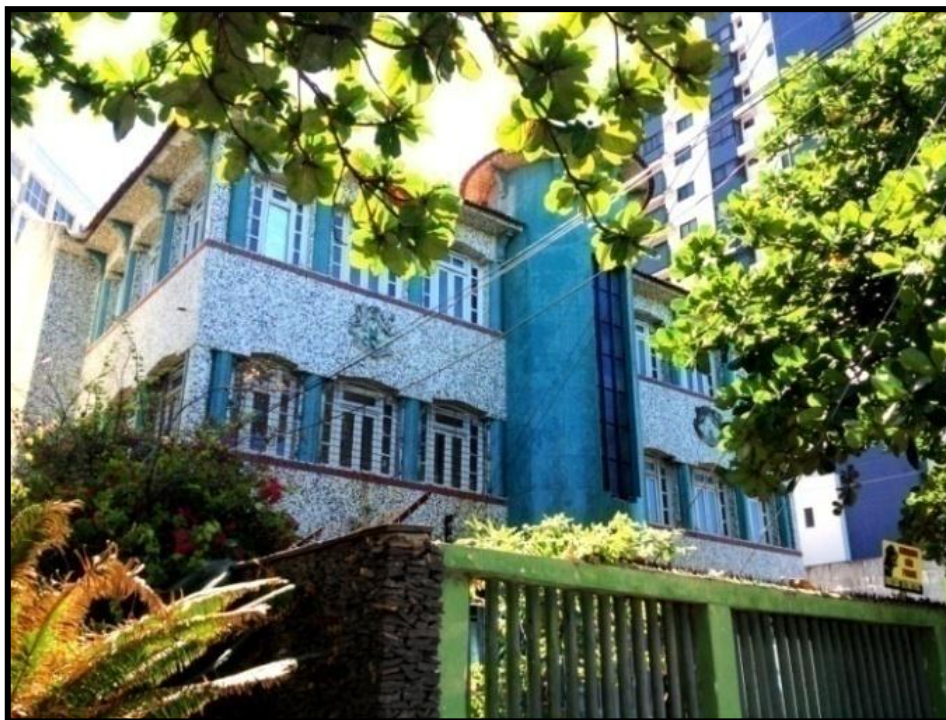
Figura - Fachada Frontal do Edifício Caiçara. Vista de longe parece em bom estado.
