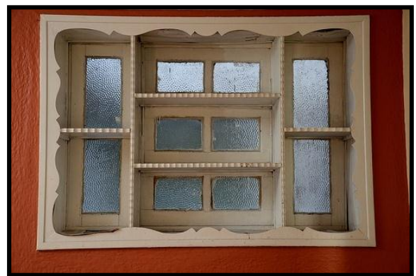
Figura - Detalhe dos ornamentos de uma das esquadrias das janelas altas, em madeira e pintadas na cor branca.
