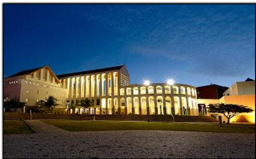
FIGURA 25: Vista do Memorial da Cultura Cearense no setor vermelho do lado oeste
