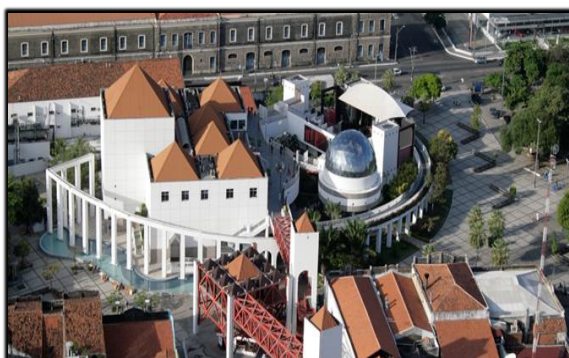
FIGURA 26: Vista aérea do setor laranja, lado leste
