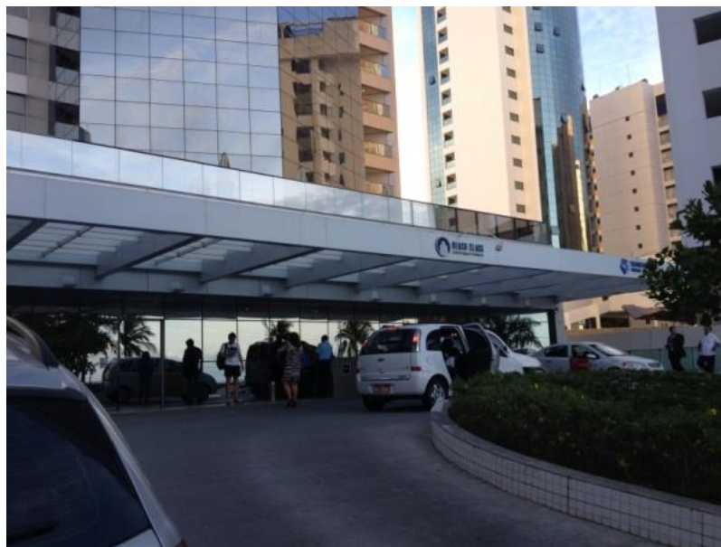
FIGURA 37 – Marquise da entrada
