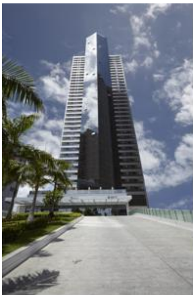
FIGURA 36 – Rampa de acesso.
