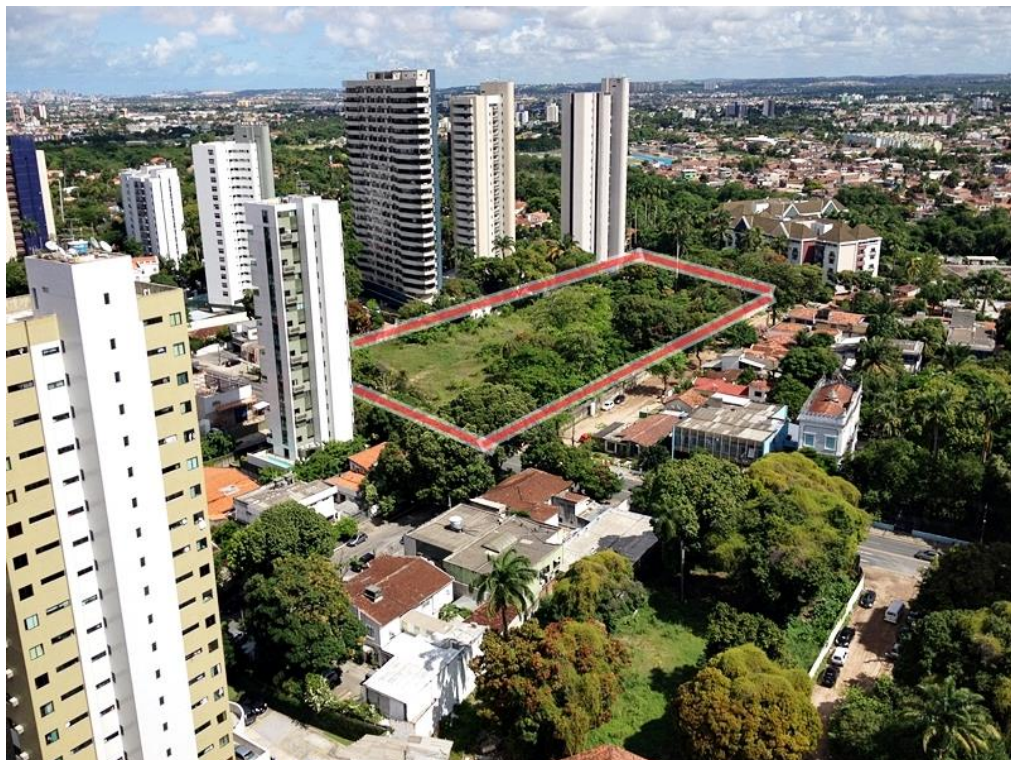
FIGURA 66 – Vista do terreno em maio de 2013, após a demolição da Casa de Saúde São José
