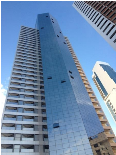
FIGURA 38 – Fachada frontal, com saliência em pano de vidros
