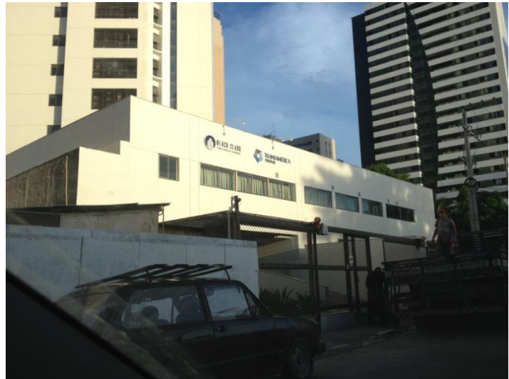
FIGURA 39 – Fachada dos fundos
