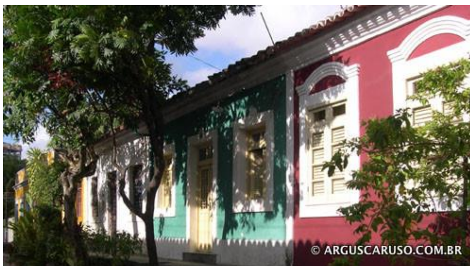
FIGURA 75 – Pórticos do casario do Poço da Panela
