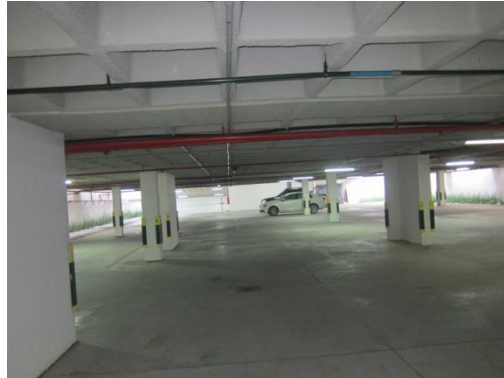
FIGURA 55 – Estacionamento do semi-enterrado
