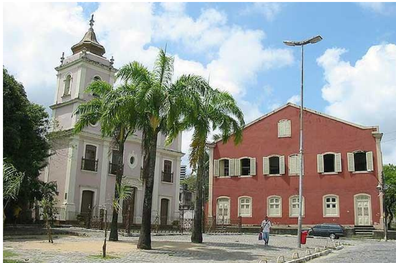
FIGURA 76 – Pórticos do casario do Poço da Panela
