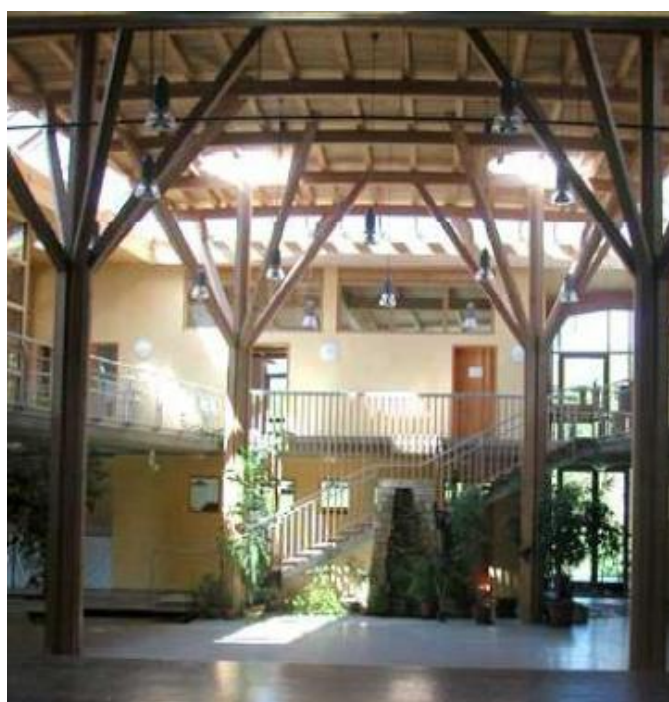
FIGURA 39: Pátio interno do bloco 01
