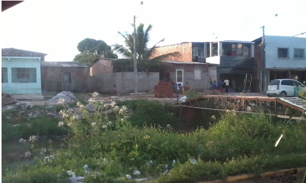
FIGURA 16 - Ponte de travessia sobre o Canal e vegetação sem manutenção.
