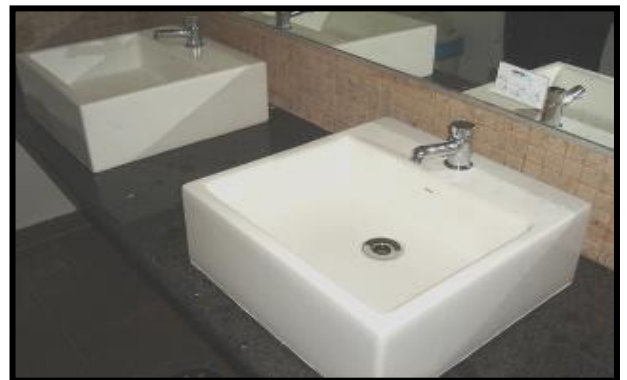
FIGURA 60: Cubas com torneiras com fluxo de água reduzidos e timer, visando o consumo consciente de água no estabelecimento.
