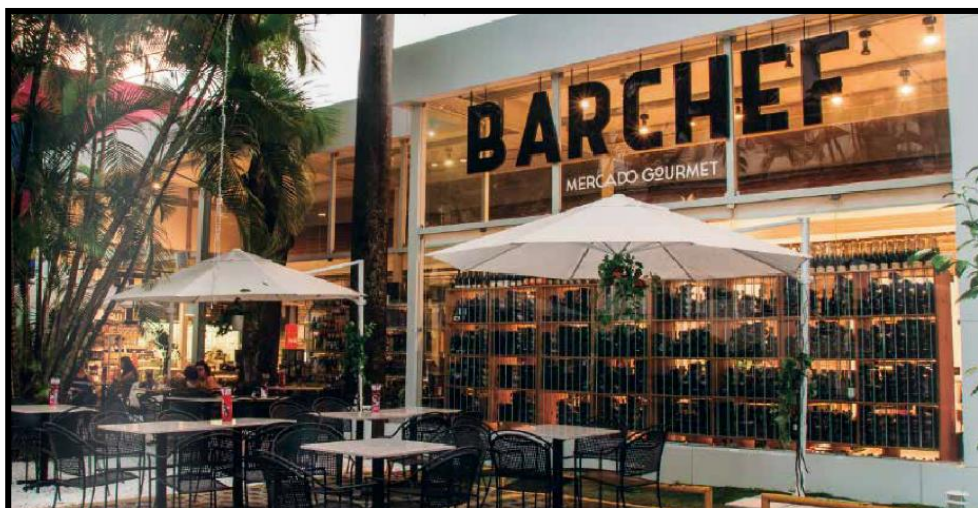
FIGURA 66: Fachada do Mercado Gourmet, com painéis em vidro e vigas metálicas, afirmando os itens que contribuíram para uma obra limpa no Barchef.
