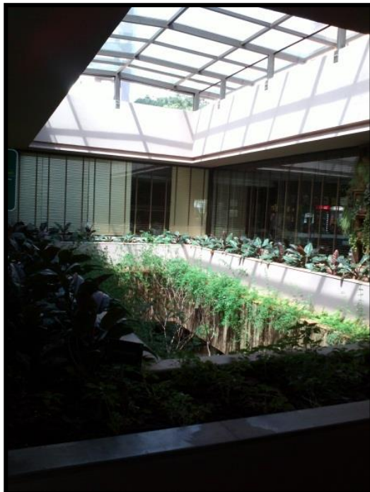
Figura 37: Dômus de iluminação.
