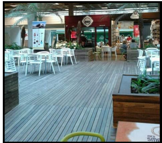
FIGURA 43: Foto mostrando o piso em madeira pinus autoclavado.
