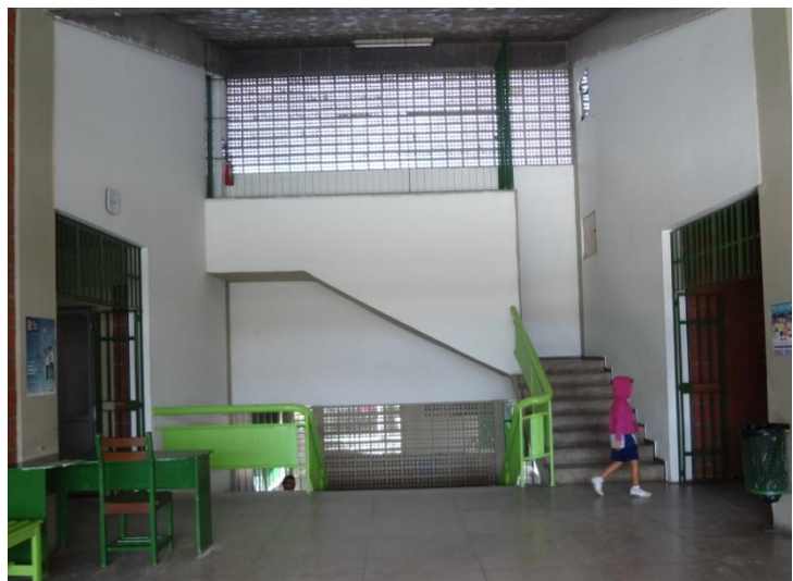
FIGURA 62: Escada- vista do 1º pavimento
