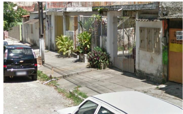
FIGURA 38: Calçada em frente à escola
