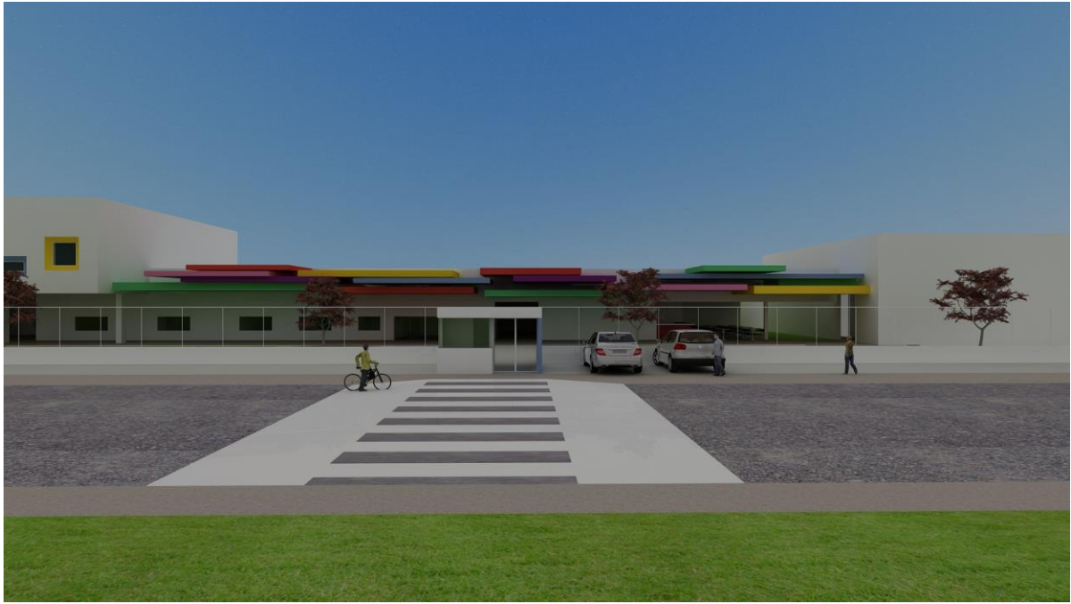
FIGURA 111- Placas revestidas em ACM
