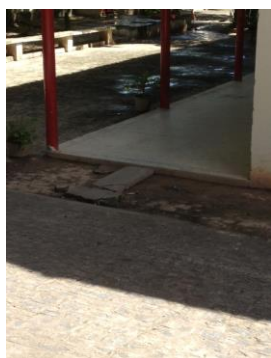
FIGURA 45- Acesso do bloco um ao dois
