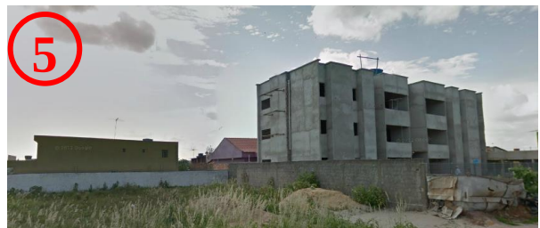
FIGURA 94- Prédios sendo construídos
