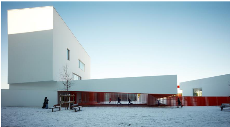
FIGURA 81- Abundante e irreverente uso do concreto
