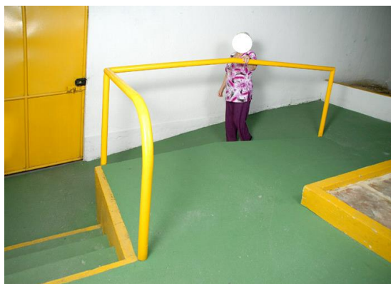
FIGURA 34: Rampa de acesso FONTE: Conviver Geriátrico, 2012.
