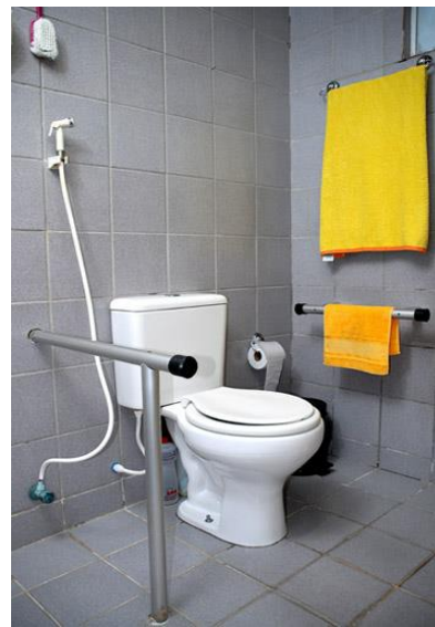
FIGURA 33: Banheiro acessível FONTE: Conviver Geriátrico, 2012.
