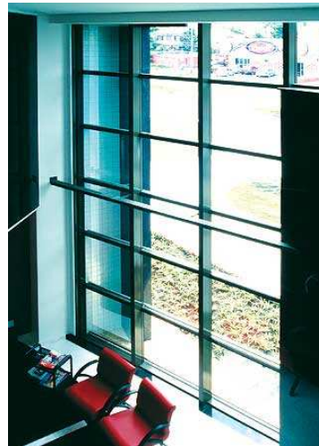
FIGURA 59: Detalhe interno da fachada, Union Day-Hospital, Curitiba/PR.
