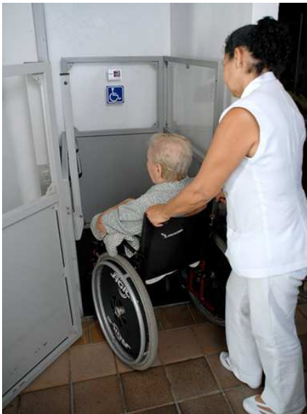
FIGURA 31: Elevador. Conviver Geriátrico, Boa Viagem/PE. FONTE: Conviver Geriátrico, 2010.
