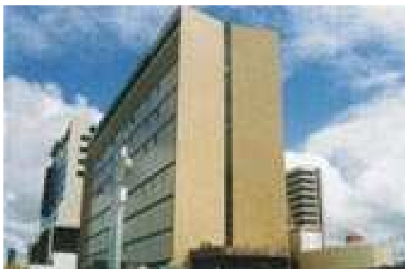
FIGURA 64: Hospital Unimed, Recife, PE. FONTE: Informazione, 2010.
