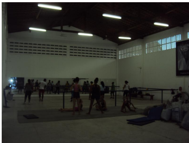
FIGURA 31: Ginásio de Ginástica: Alvenaria Estrutural, Coberta de Madeira e Abertura em Cobogó
