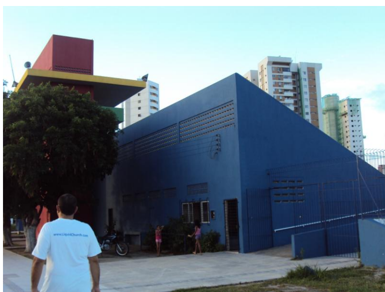
FIGURA 33: Tribuna: Alvenaria Estrutural, Coberta em Laje e Abertura em Cobogó
