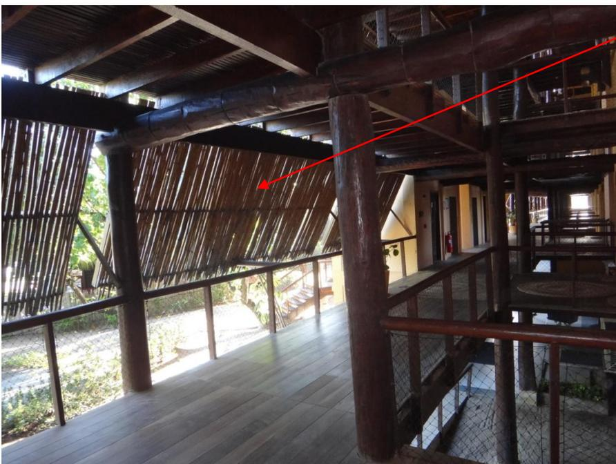
Elemento protetor solar que permite a permeabilidade dos ventos
