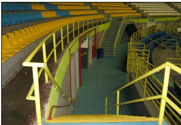
FIGURA 172: Acesso banheiro público FONTE: Acervo da autora, 2012.
