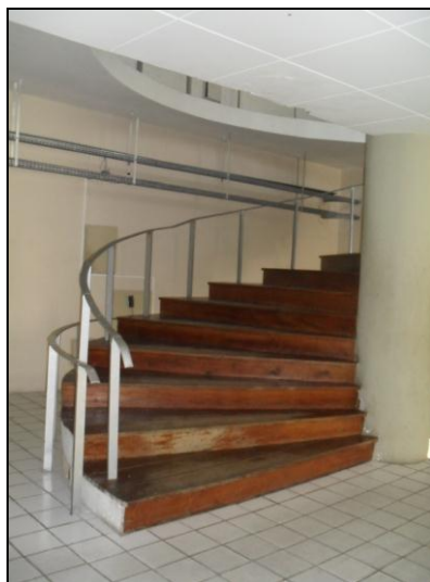
FIGURA 105: Escada Helicoidal FONTE: Acervo da autora, 2012.
