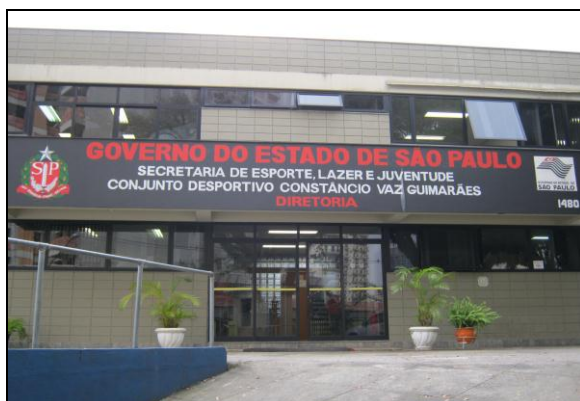
FIGURA 200: Prédio Administrativo FONTE: Acervo da autora, 2012.
