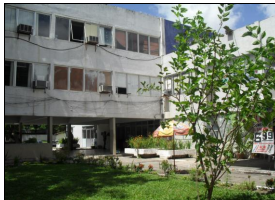
FIGURA 104: Prédio Administrativo FONTE: Acervo da autora, 2012.
