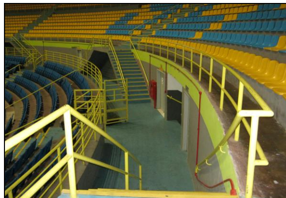
FIGURA 173: Acesso banheiro público FONTE: Acervo da autora, 2012.
