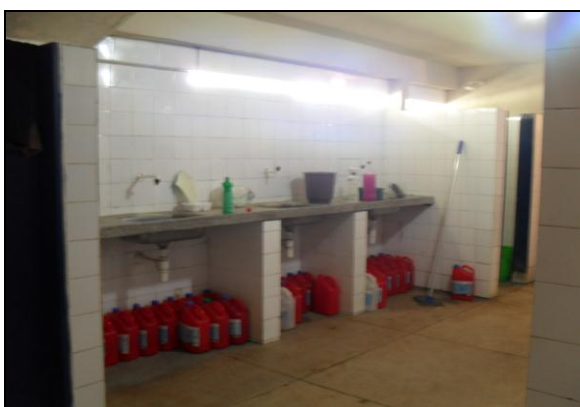
FIGURA 143: Vestiário feminino (abertura longitudinal) FONTE: Acervo da autora, 2012.
