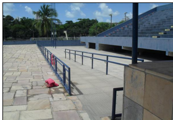
FIGURA 123: Rampa de acesso FONTE: Acervo da autora, 2012.
