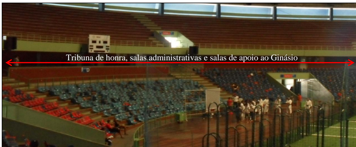
FIGURA 70: Circulação (Tribuna de honra, salas administrativas e salas de apoio ao Ginásio)
