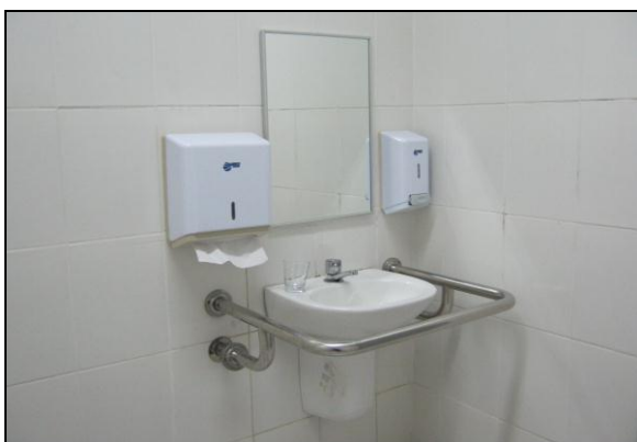
FIGURA 176: Pia adaptada – Wc P.N.E FONTE: Acervo da autora, 2012.
