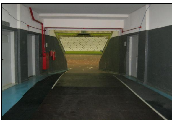
FIGURA 166: Acesso arquibancadas térreas FONTE: Acervo da autora, 2012.
