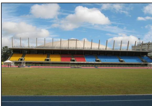
FIGURA 186: Estádio Ícaro de Castro Mello
