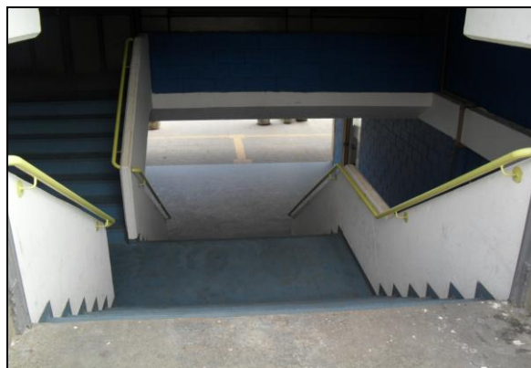
FIGURA 189: Escada de acesso às arquibancadas do Estádio.
