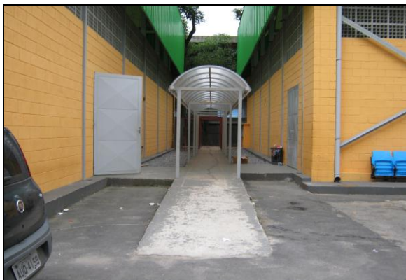
FIGURA 182: Rampa de acesso às quadras poliesportivas cobertas.
