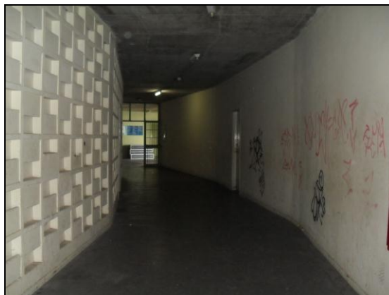
FIGURA 67: Circulação (Abaixo das arquibancadas) FONTE: Acervo da autora, 2012.
