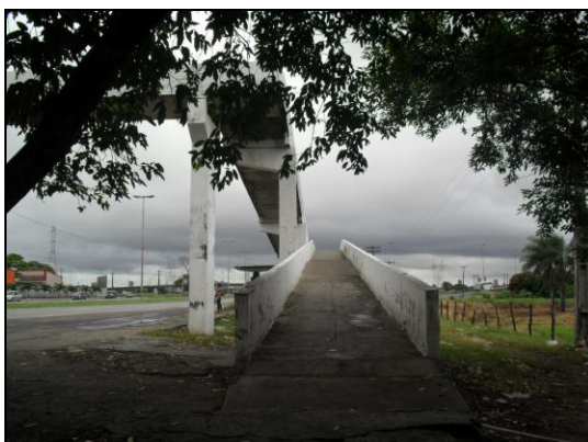
FIGURA 212: Passarela da CEASA FONTE: Acervo da autora, 2012.
