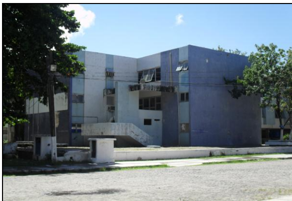
FIGURA 103: Prédio Administrativo FONTE: Acervo da autora, 2012.
