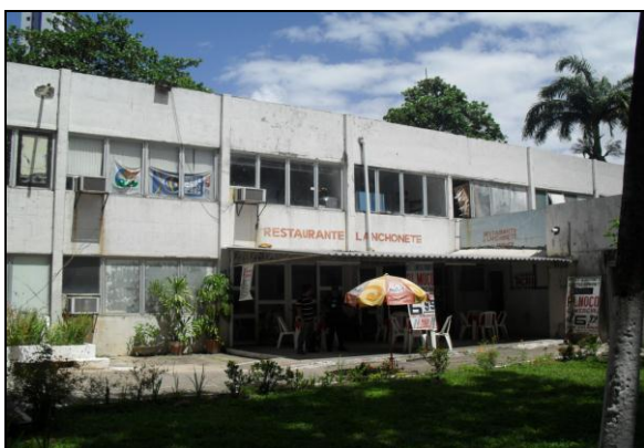
FIGURA 155: Fachada do Restaurante FONTE: Acervo da autora, 2012.
