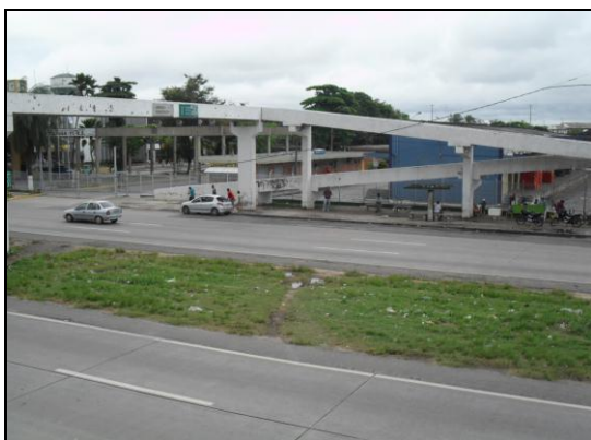
FIGURA 211: Passarela da CEASA FONTE: Acervo da autora, 2012.
