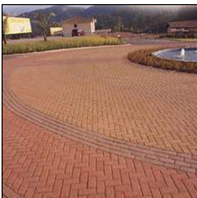
FIGURA 26: Piso em bloco de concreto intertravado. FONTE: www.glasser.com.br
