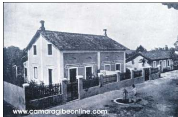
FIGURA 112: Fontes de Água na vila operária de Camaragibe.
