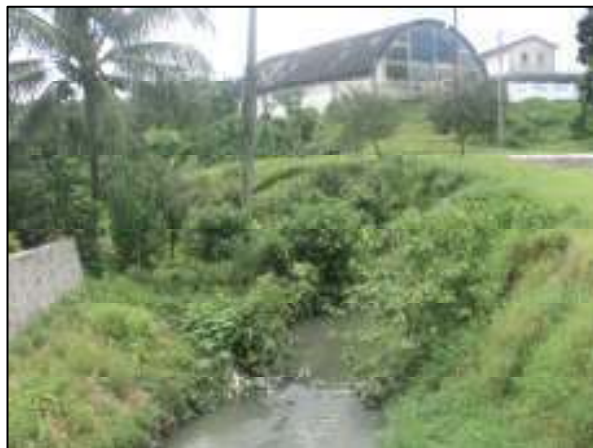
FIGURA 139: Canal na lateral da Praça de Eventos.
