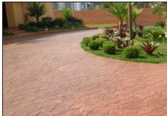
FIGURA 23: Piso de concreto imitando desenhos de pedra. FONTE: Google imagens, 2012.
