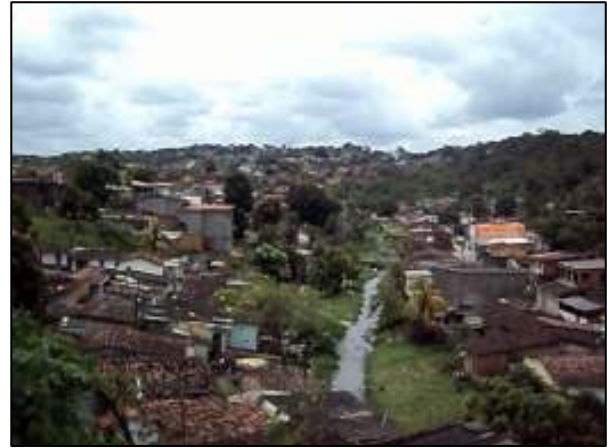
FIGURA 115: Casas nas margens do Rio Camaragibe FONTE: Autora da pesquisa, 2011.
