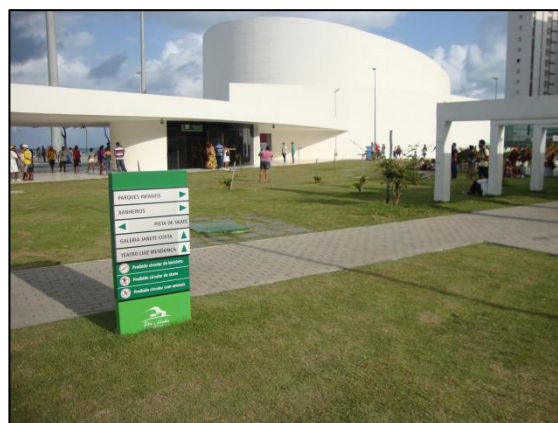
FIGURA : estruturas em concreto armado revestido com tinta.
