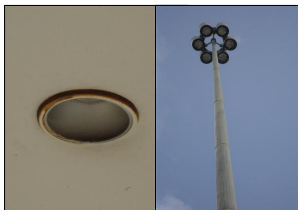
FIGURA : Luminária embutida com acabamento em ferro e postes de concreto do Parque Dona Lindu
