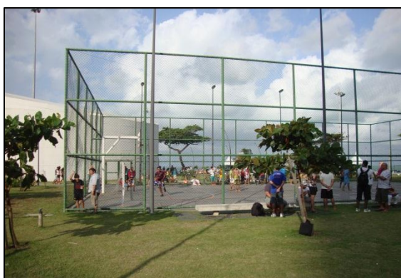
FIGURA : Quadra poliesportiva cercada por tela de alambrado pintado e piso de cimento queimado.
