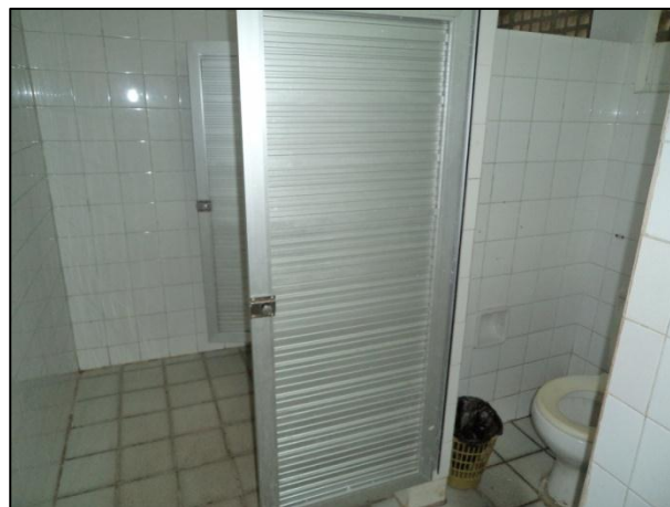
FIGURA : Sanitário feminino do Parque da Jaqueira. FONTE: A autora, 2012.
