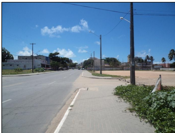
FIGURA : Vista Sentido Centro da Av. Presidente Kennedy.
