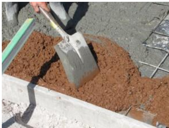
FIGURA : Aplicação de asfalto pigmentado.
