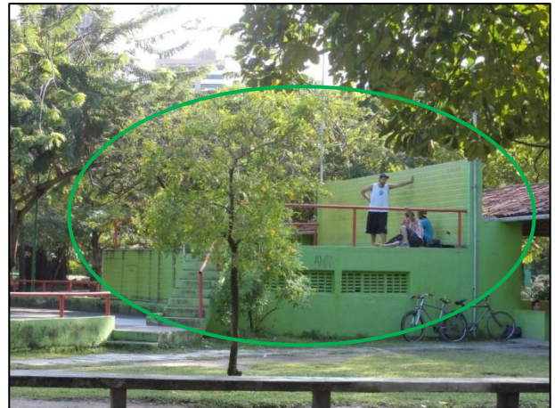
FIGURA : Depósito do Parque da Jaqueira.
