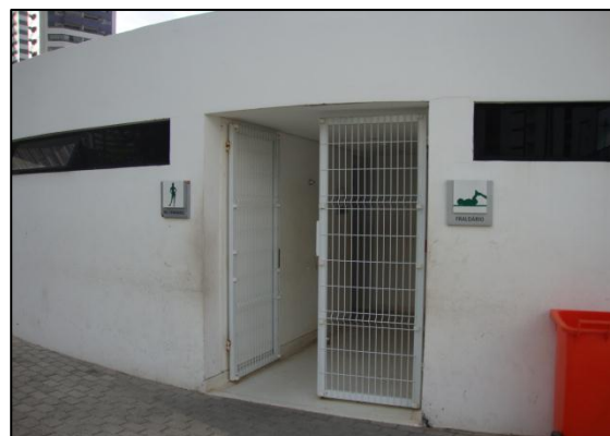
FIGURA : Fraldário em estrutura de concreto armado rebocado e pintado.
