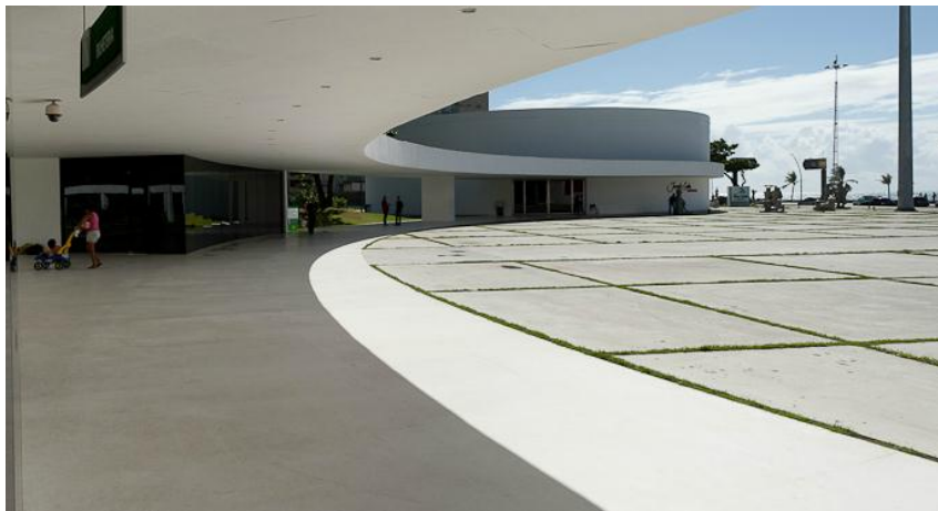
FIGURA 23: Vista do acesso a Galeria sobre marquise.
