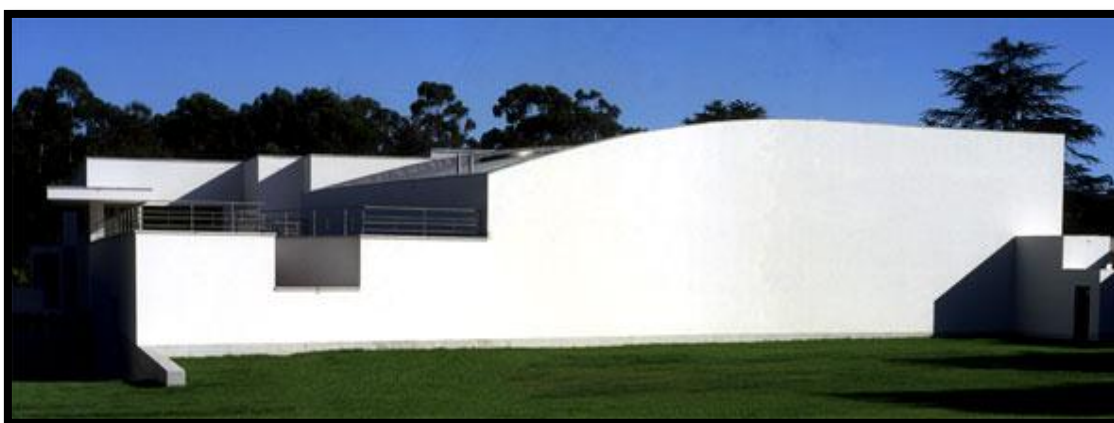
FIGURA 14: Vista lateral do Museu da Fundação Serralves, a observar os respectivos volumes e o seu escalonamento .
