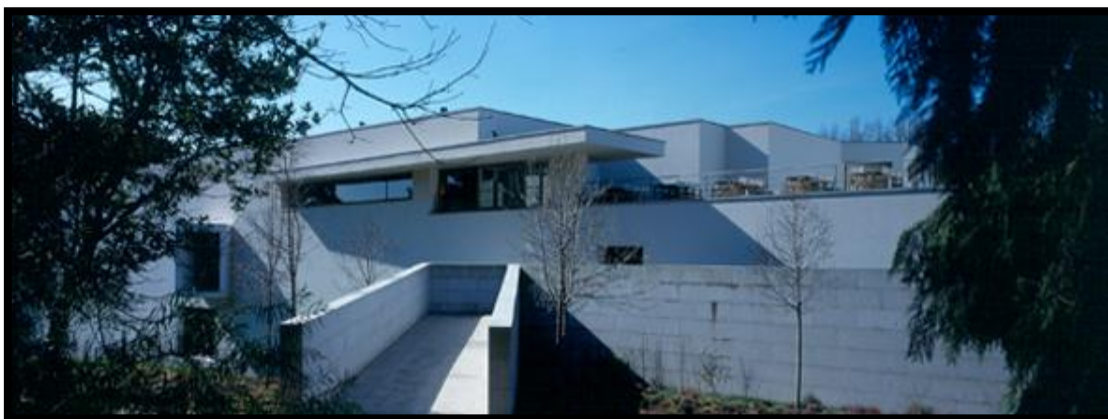
FIGURA 13: Vista da passarela de acesso ao museu.
