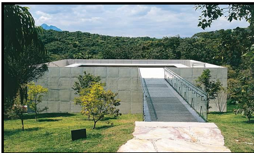
FIGURA 11: Vista do terraço | cobertura da Galeria. FONTE: Autor da pesquisa. 2012.
