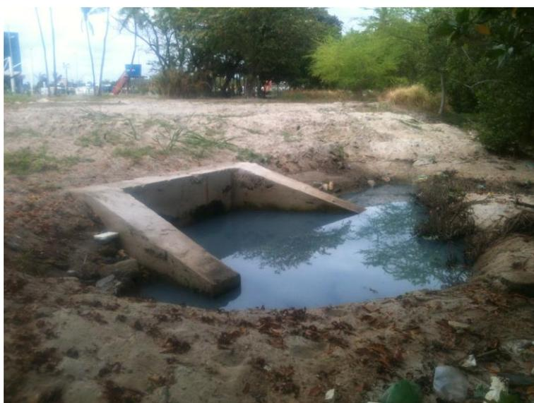
**FIGURA 67:** Ponta de Ala com ligação de esgoto
