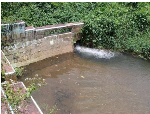
FIGURA 91: Rio que atravessa o terreno. FONTE: Autora, 2012.
