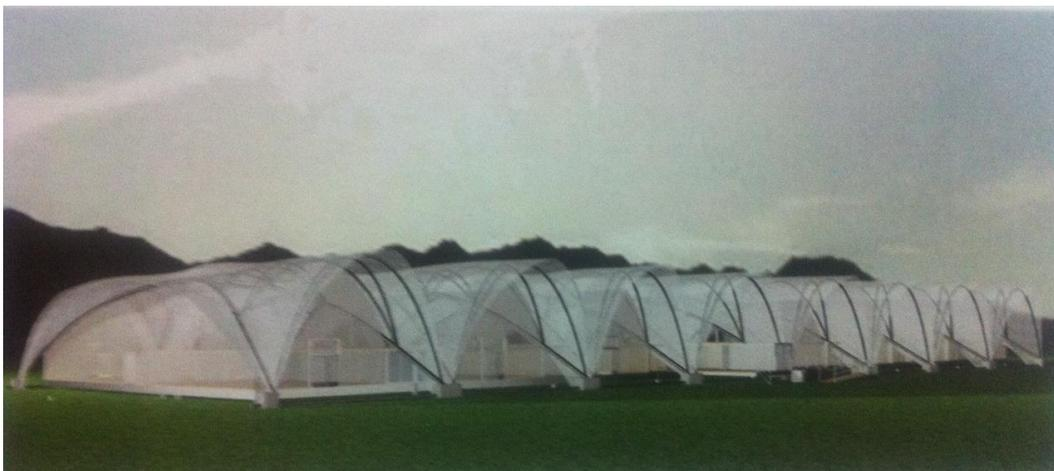
**FIGURA 10:** Coberta pneumática do protótipo modular.
