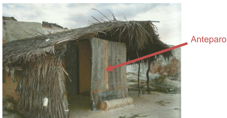
FIGURA 9: Anteparo posto a entrada da casa para barrar a força do vento.
