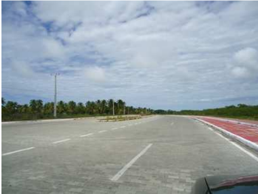
FIGURA 123: Estrada de acesso a Maracaípe. FONTE: Gabriel Beltrão, Maio, 2011
