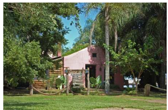
FIGURA 104: Bateria de banheiros. FONTE: Gabriel Beltrão, Maio, 2011
