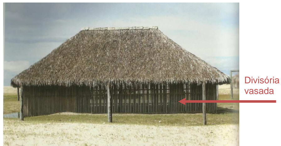
FIGURA 18: Casa de pescador com paredes em toras de madeira espaçadas entre si. FONTE: Barros Lima Junior, 2007 p.72.
