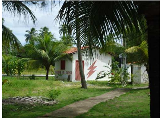
FIGURA 78: Casa do gerador. FONTE: Gabriel Beltrão, Maio, 2011
