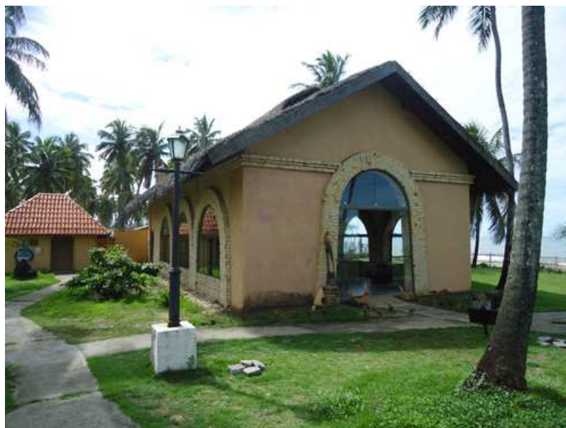
FIGURA 79: Refeitório com wc de apoio. FONTE: Gabriel Beltrão, Maio, 2011
