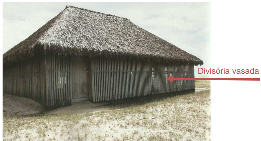
FIGURA 20: Casa de pescador com paredes em toras de madeira espaçadas entre si. FONTE: Barros Lima Junior, 2007 p.104.
