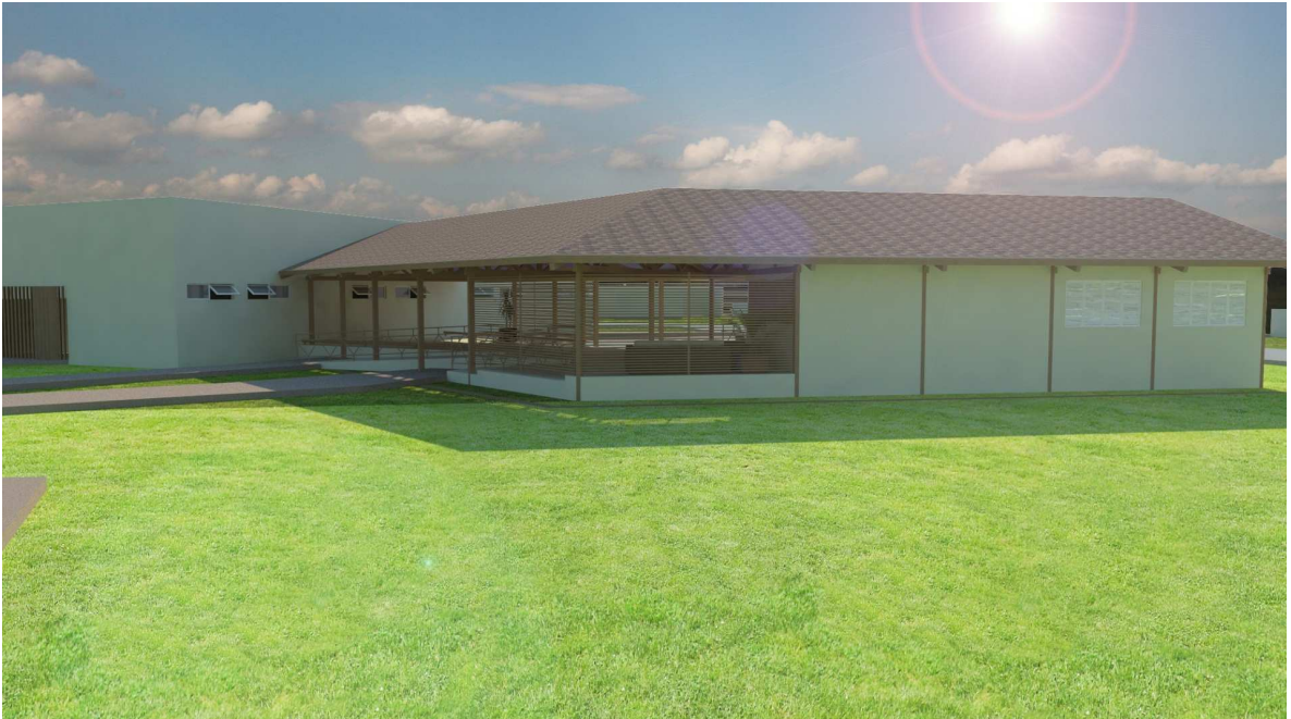
FIGURA 136: Vista posterior do bloco administrativo. FONTE: Gabriel Beltrão, Novembro, 2011
