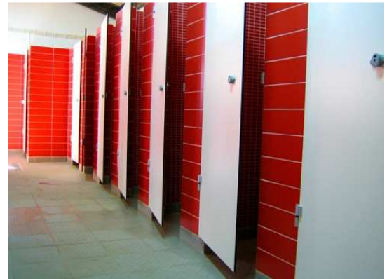
FIGURA 117: Área interna da bateria de banheiros. FONTE: FONTE: http://www.campingsaomiguel.com , 2011
