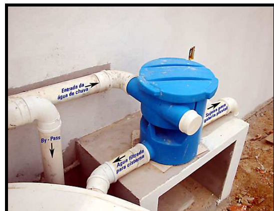
FIGURA 23: Sistema de Armazenamento. FONTE: http://www.agua-de-chuva.com/
