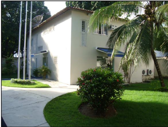
FIGURA 61: Vista setor administrativo FONTE: Acervo do autor, 2011.
