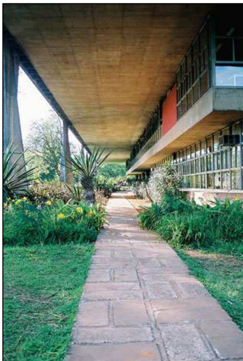
FIGURA 44: Vista jardim externo. FONTE: http://arqpb.blogspot.com , acesso em maio 2011.
