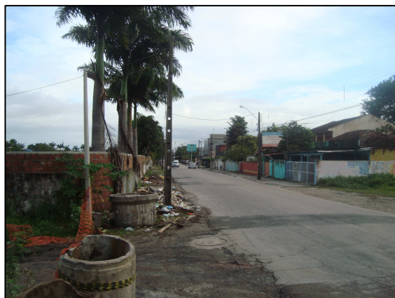
FIGURA 80: Vista da Rua Carlos Gomes. FONTE: Acervo do autor, 2011.
