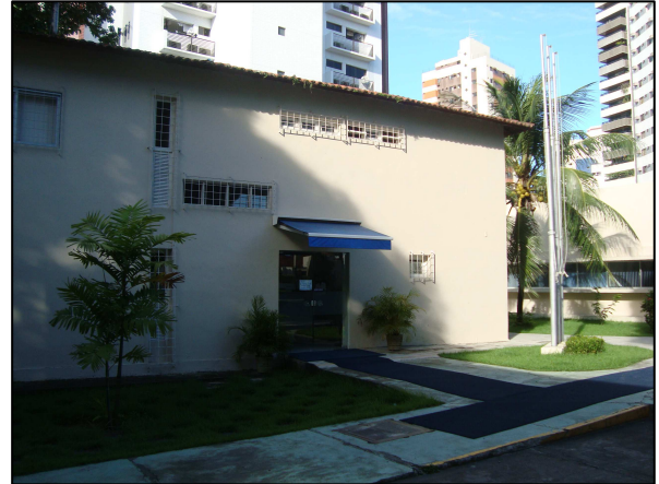
FIGURA 62: Vista setor administrativo FONTE: Acervo do autor, 2011.
