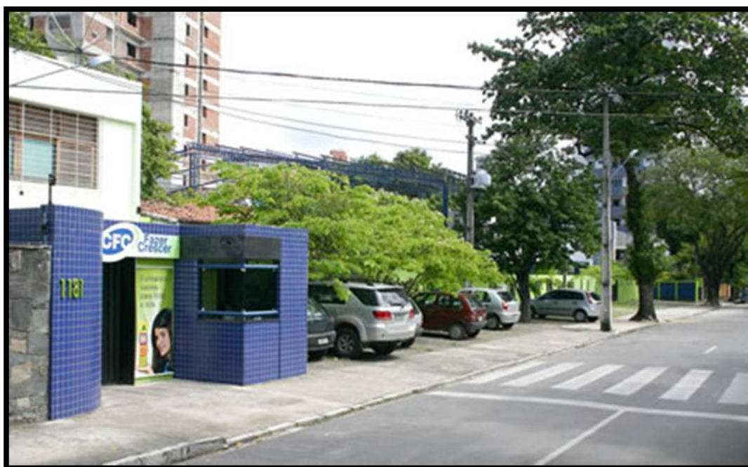
FIGURA 75: Acesso principal desrespeitando as normas de acessibilidade .
