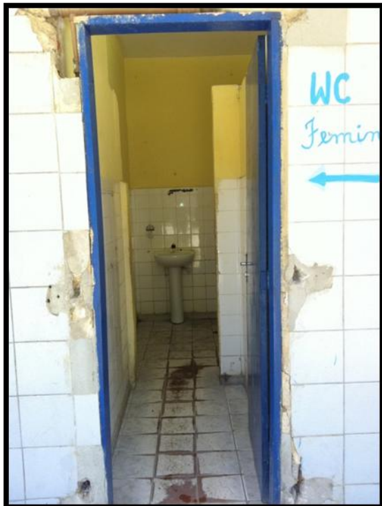
FIGURA 103: Banheiros não acessíveis. FONTE: Autora, 2011.
