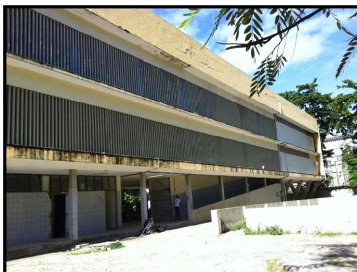
FIGURA 93: Fachada voltada para o poente, protegida pro brises – Escola Cônego Rochael de Medeiros. FONTE: Autora, 2011.
