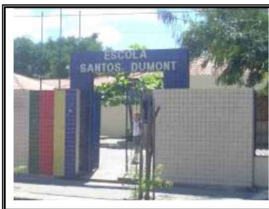
FIGURA 46: Acesso principal . FONTE: Autora, 2011.
