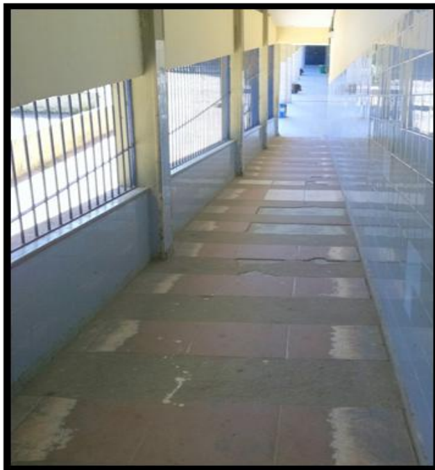
FIGURA 101: rampas íngrimes e com piso quebrado – Escola Cônego Rochael de Medeiros. FONTE: Autora, 2011.
