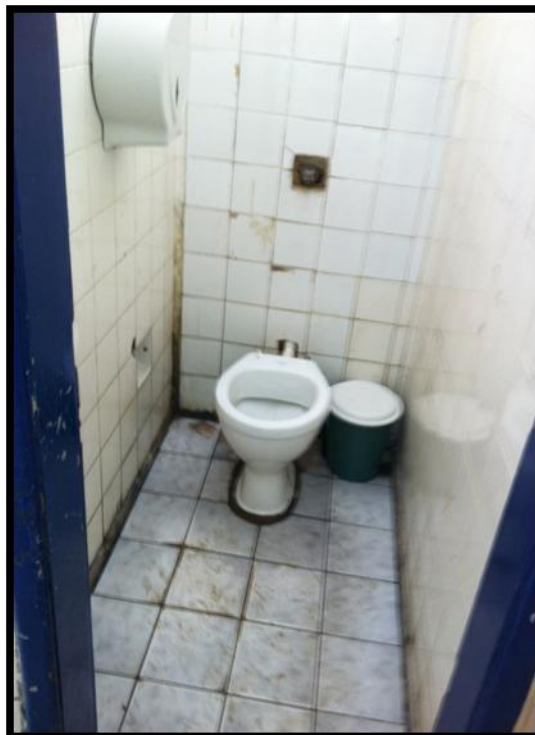
FIGURA 104: Banheiros não acessíveis. FONTE: Autora, 2011.
