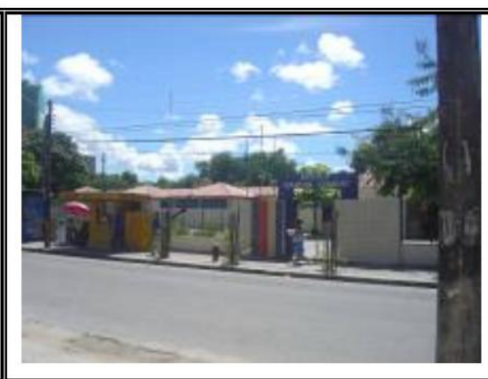
FIGURA 47: Acesso principal. FONTE: Autora, 2011.
