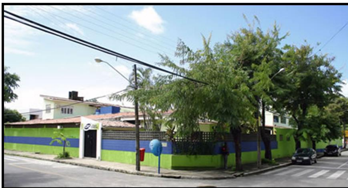
FIGURA 74: Muros voltados para a área externa. FONTE: www.cfcvirtual.com.br .
