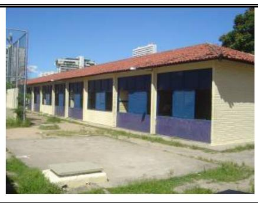
FIGURA 60: Fachada Poente. FONTE: Autora, 2011.
