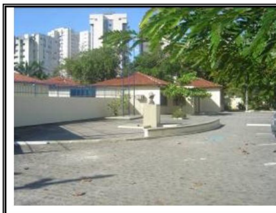
FIGURA 48: Pátio e entrada principal. FONTE: Autora, 2011.
