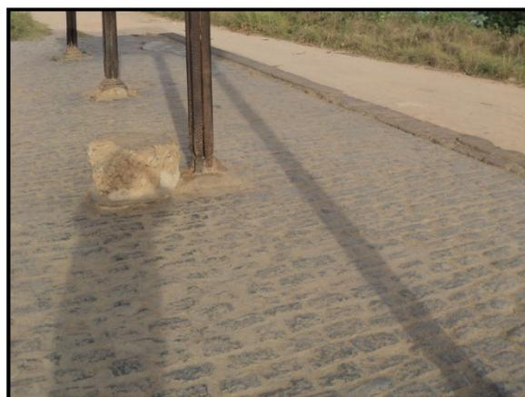
**FIGURA 128:** Piso em paralelepípedo
