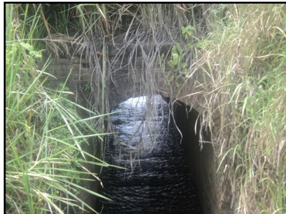
**FIGURA 101:** Pontilhão para passagem da ferrovia
