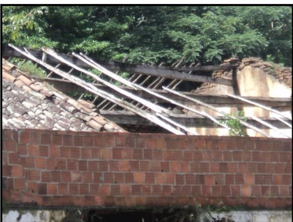
**FIGURA 167:** Estrutura precária de cobertura
