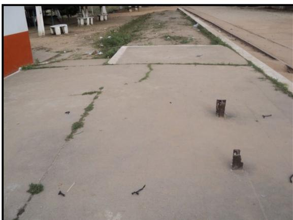
**FIGURA 141:** Vegetação na plataforma cimentada
