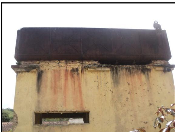
**FIGURA 109:** Pilares e alvenaria de vedação
