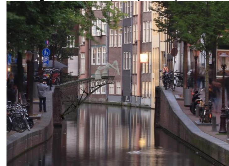
Figura 56 - Construção da ponte de pedestre
