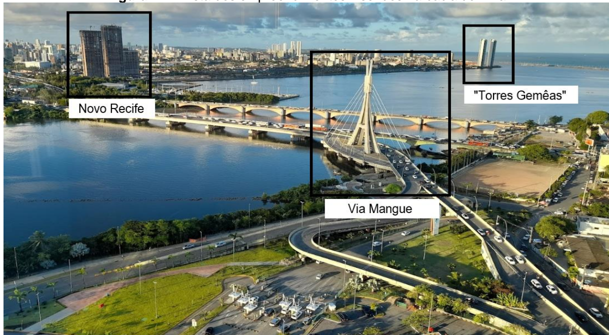
Figura 27 – Vista dos empreendimentos inseridos na bacia do Pina
