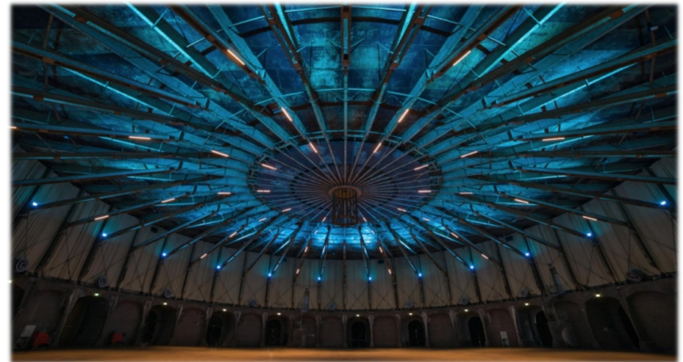
Figura 45 – Parte interna do Gashouder com iluminação montada. Fonte: CLS, 2018.
