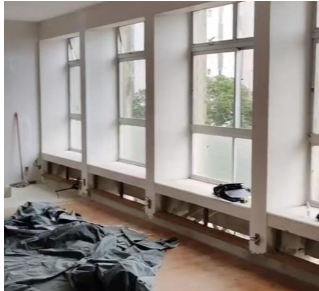
Figura 31 - Bancos ventilados - Edf. Duque de Bragança, 1970 – Delfim Amorim e Heitor Maia Neto. Derby, Recife. Fonte: Siqueira, 2021
