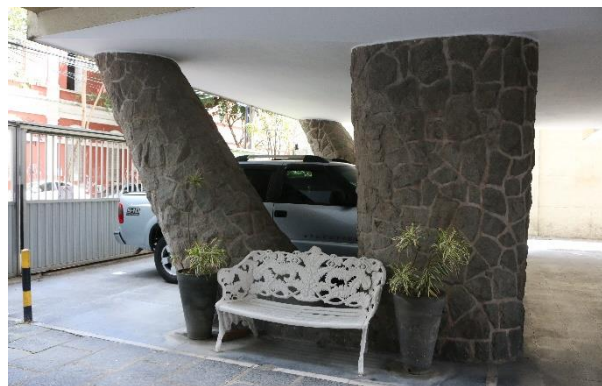
Figura 22 - pilares em V, Edf. União, 1953 - Borsoi. Bairro da Boa Vista. Recife. Fonte: autora, 2021.
