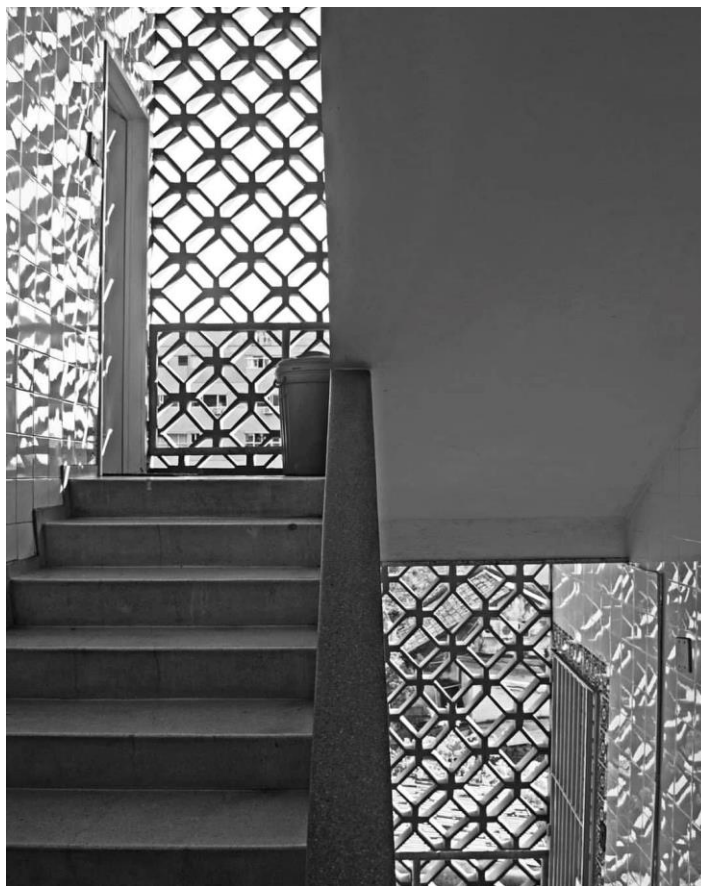
Figura 71 - Edifício União - Escada
