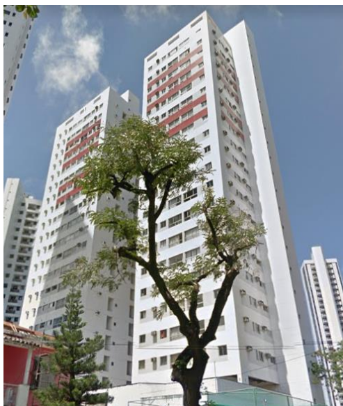
Figura 58 - Edf. Morada Real da Torre, 2010 – Torre, Recife. Fonte:Google Street View, 2019
