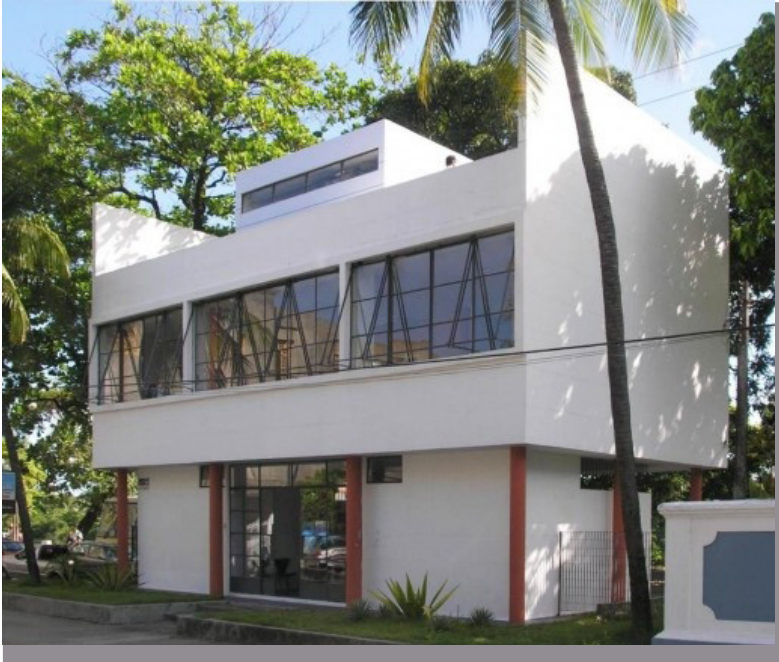
Figura 30 ■ Casa modernista no Recife, em destaque o pilotis de concreto em forma de "V" e a marquise prolongada trazendo sombreamento ao local. Fonte ■ Vogue, acesso 2021
