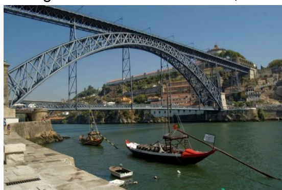
Figura 8 – Ponte de D. Luís, Porto.
