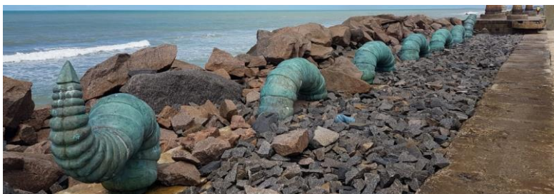
Figura 72 – obras do Parque das Esculturas apoiada no Arrecife.
